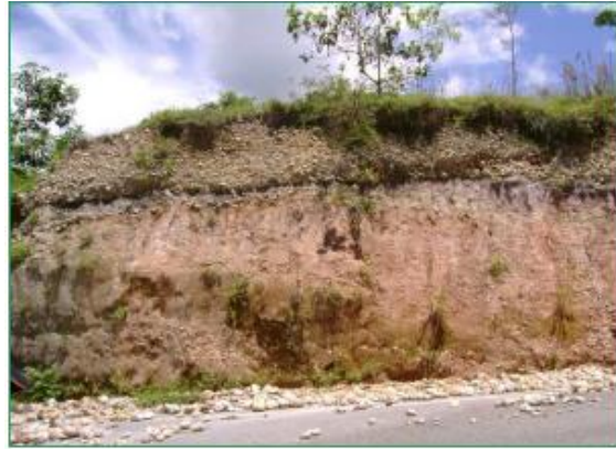
Imagen 10. Depósitos de bloques, grava, arena y finos típicos de terrazas aluviales. Talud Interno. Vía Marginal del Llano. Fuente: Estudio Cartografía Geológica del Suroeste de Casanare. INGEOMINAS. 2007
