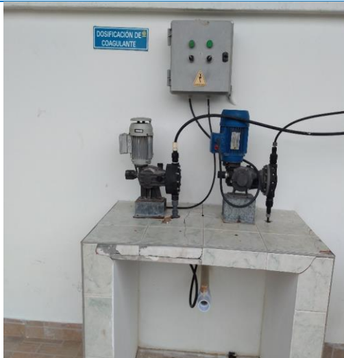
Ilustración 1. Dosificador de coagulante
