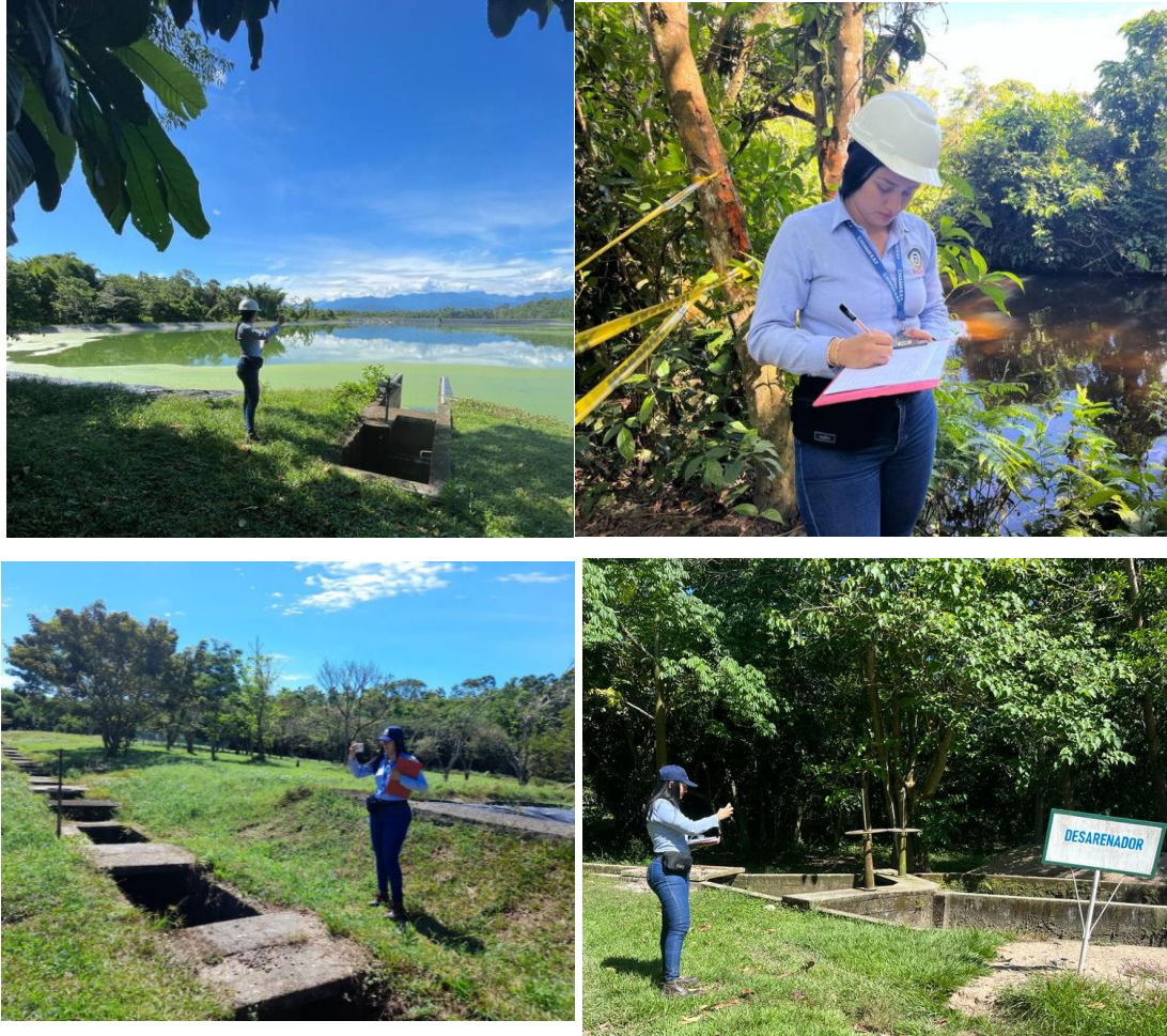
Figura 48. Inspección de control en la planta de tratamiento
