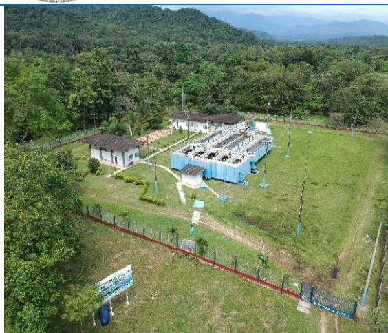
Cerramiento perimetral en buenas condiciones y ruta de evacuación.
