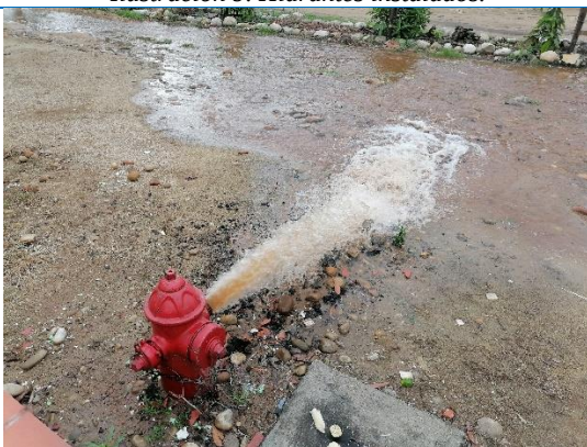
Ilustración 11. Manipulación de purgas instaladas
