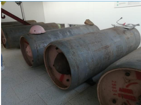
Almacenamiento de cloro gaseoso.
