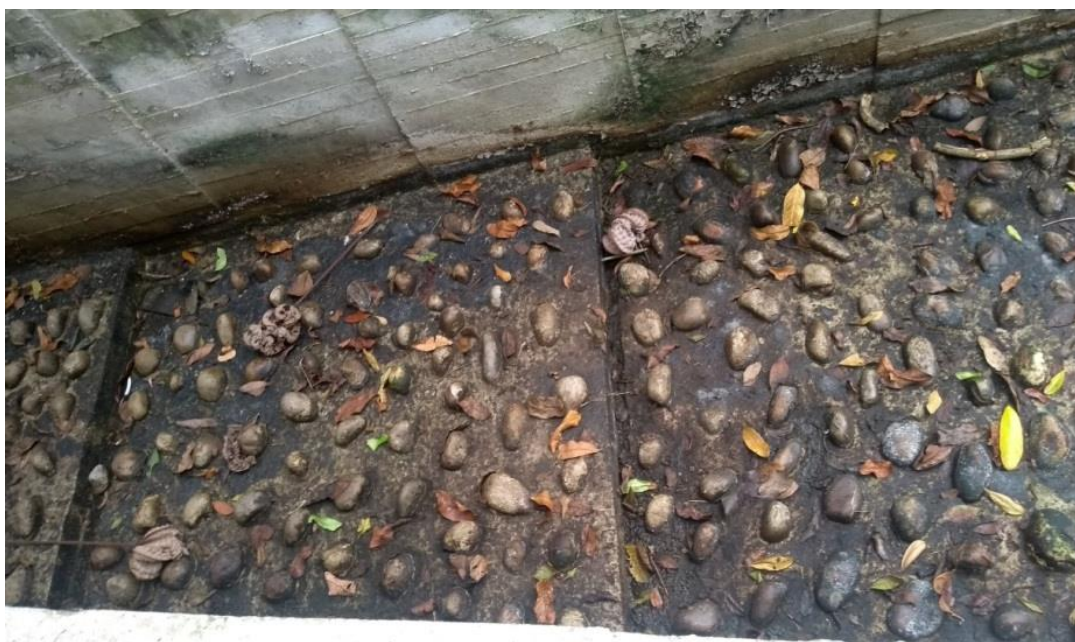
Figura 40. Reductor de energía.
