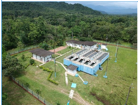
Vista general de la PTAP
