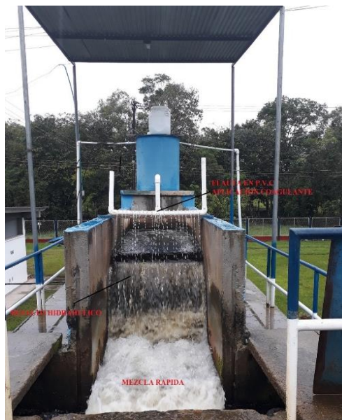
Figura 14. Resalto hidráulico y mezcla rápida
