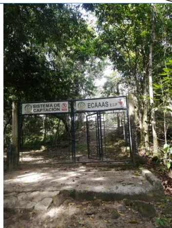
Vista de entrada a sitio de captación de la cuenca Satocá.
