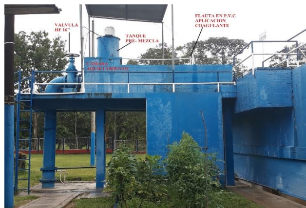
Figura 15. Estructura de llegada
