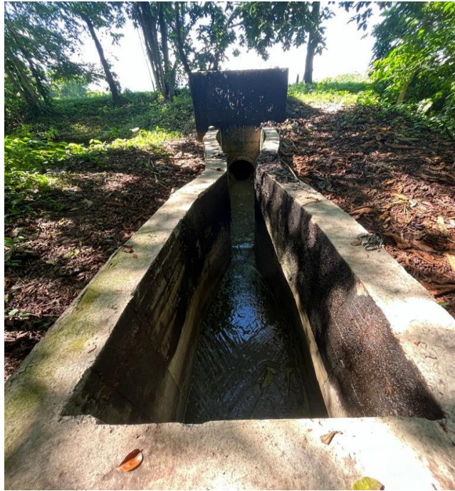
Figura 38.. Canaleta Parshal Antes Del Vertimiento
