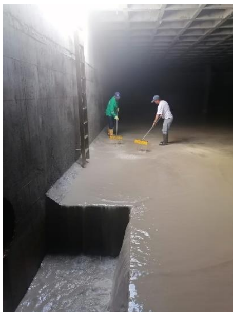
Figura 23. Lavado l tanque de almacenamiento
