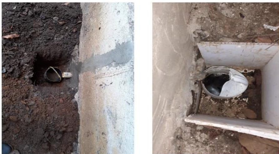
FIGURA 21. Adecuacion e instalado de recipientes para la recoleccion del lixiviado.
