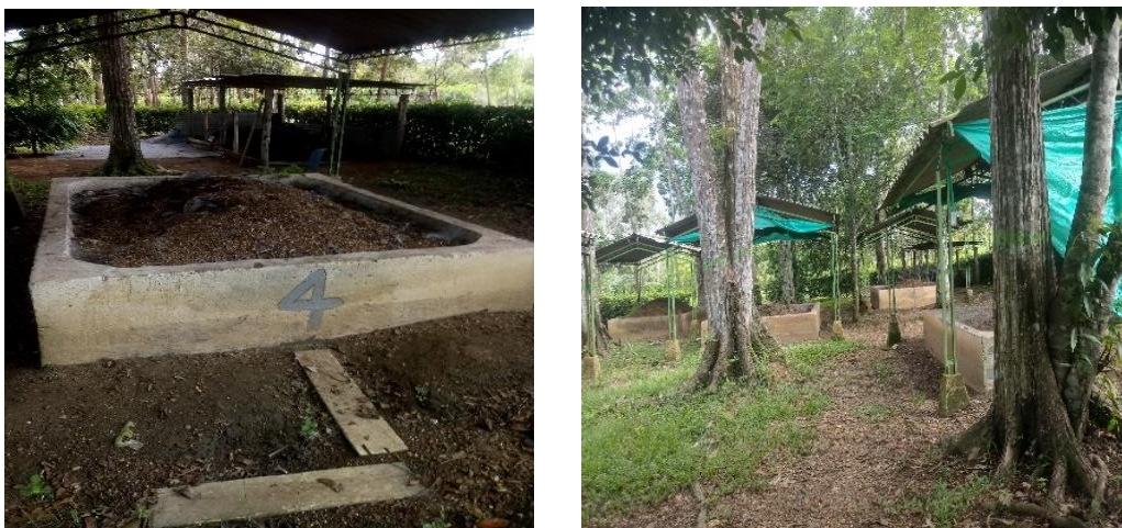
FIGURA 17. Evidencia del estado en que se encontró la zona.
