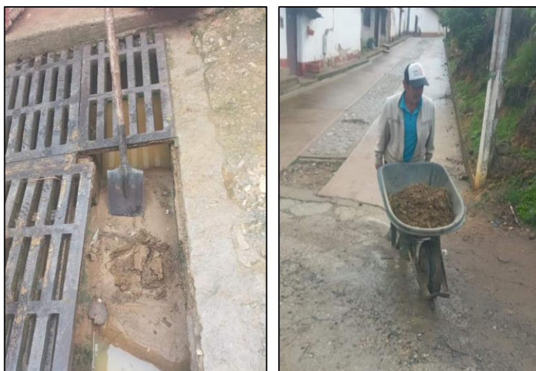
Ilustración 35. Limpieza de alcantarilla
