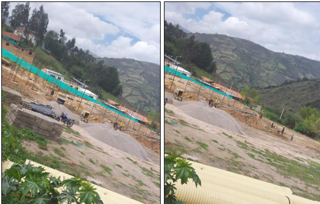
Ilustración 31. Construcción cancha, aprovechamiento RSCD
