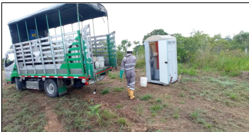
Ilustración 27 Suministro de agua y mantenimiento de unidad sanitaria
