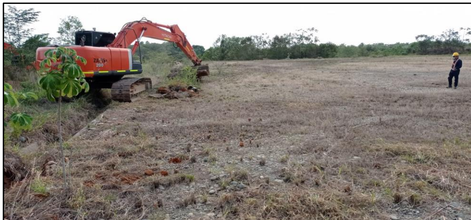
Ilustración 44 Demolición de concreto, Godric Norte-1
