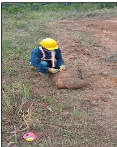
Ilustración 42 Limpieza Y Envoltura De Geotextil
