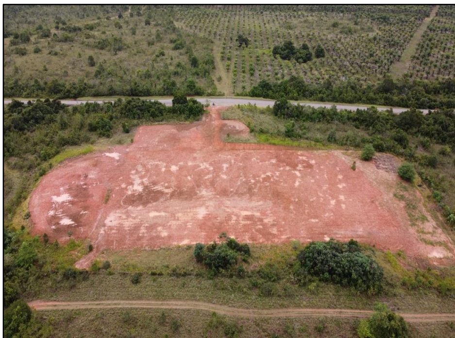
Ilustración 34 Plataforma Godric Norte -1 después de ser intervenida
