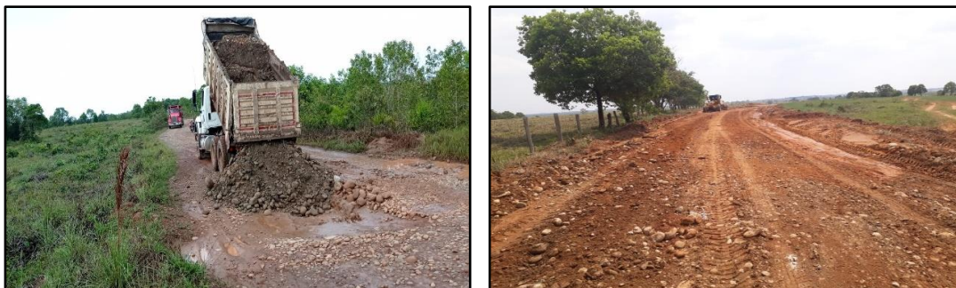
Ilustraci n 50 Mantenimiento V  Terciaria Ved Chafurray
