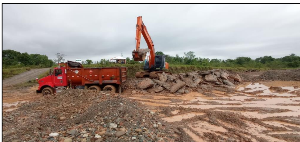
Ilustración 45 Transporte De Escombros De Construcción
