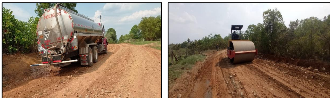
Ilustraci n 51 Mantenimiento V  Terciaria Ved Chafurray
