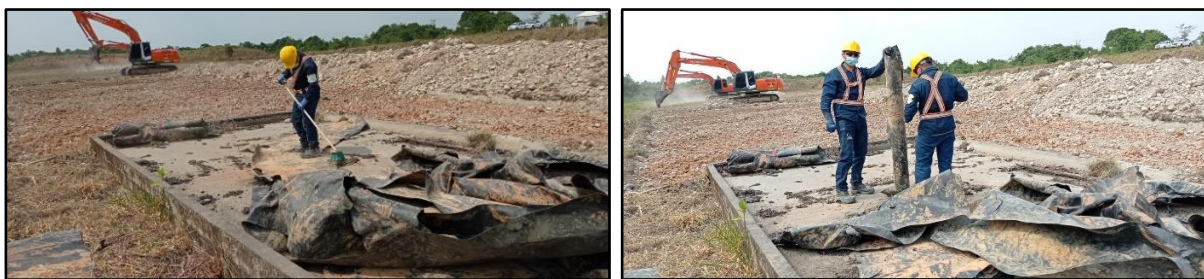
Ilustración 43 Limpieza Y Envoltura De Geomembrana
