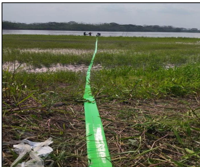
Ilustración 23 Instalación de manguera de bombeo
