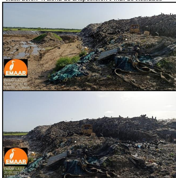
Ilustración 4. Zona de Disposición Final de Residuos
