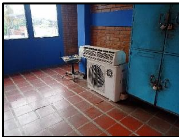
Figura 2. Primer Piso de la Planta de tratamiento
