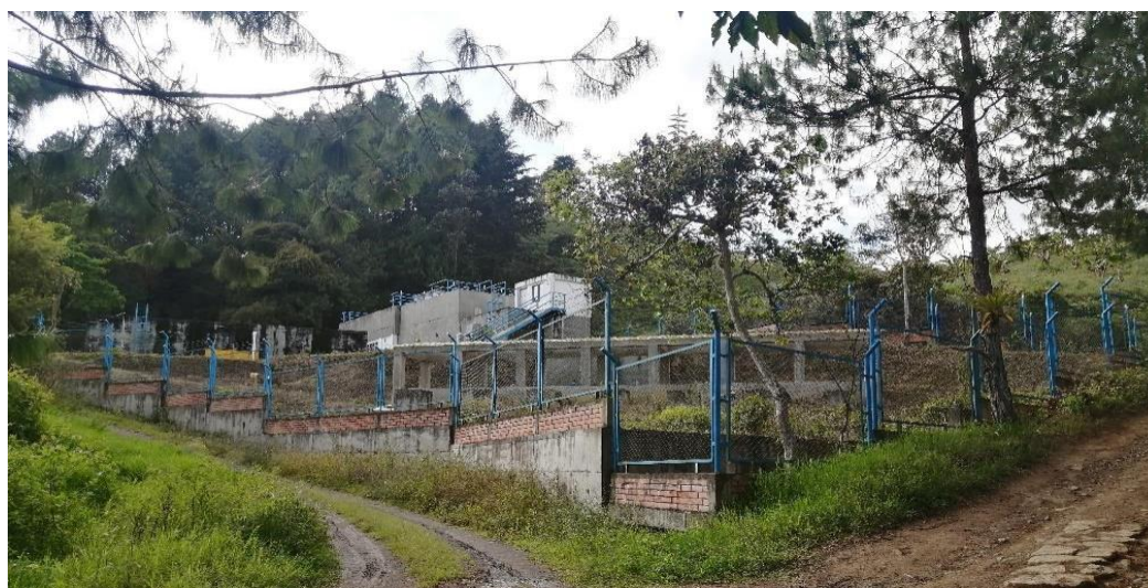
Figura 32 Estado Actual de la sede Planta de Tratamiento de Agua Potable
