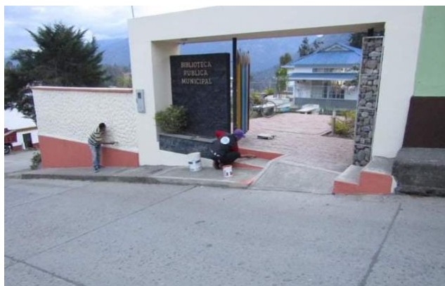
Figura 13 Estado Actual de la sede Biblioteca municipal
