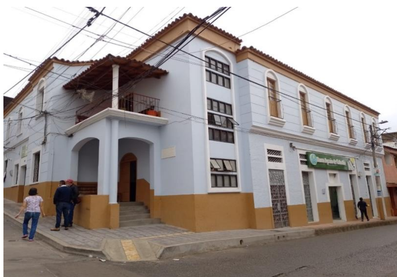
Figura 8 Estado Actual del Palacio municipal (Antiguo)
