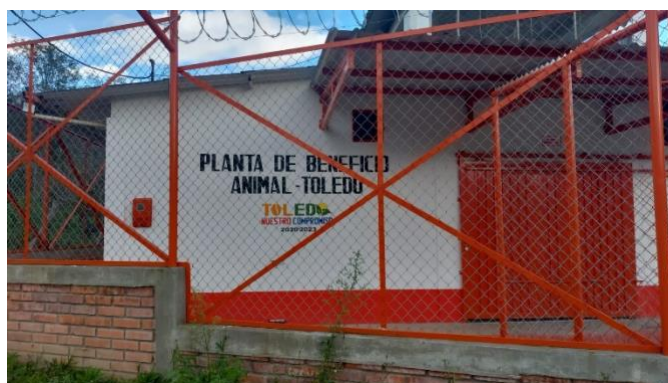
Figura 47 Estado Actual de la sede Planta de Beneficio Animal
