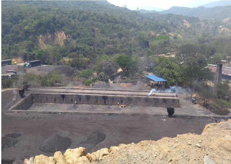
*Ilustración 3: imagen de distribución de hornos de coque en una batería, FUENTES: fotografía tomada por el ingeniero ANDRÉS ALEJANDRO IBARRA CRUZ*
