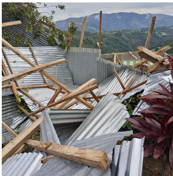
Ilustración 9 Afectación vivienda por Avenida torrencial vereda Mesopotamia
