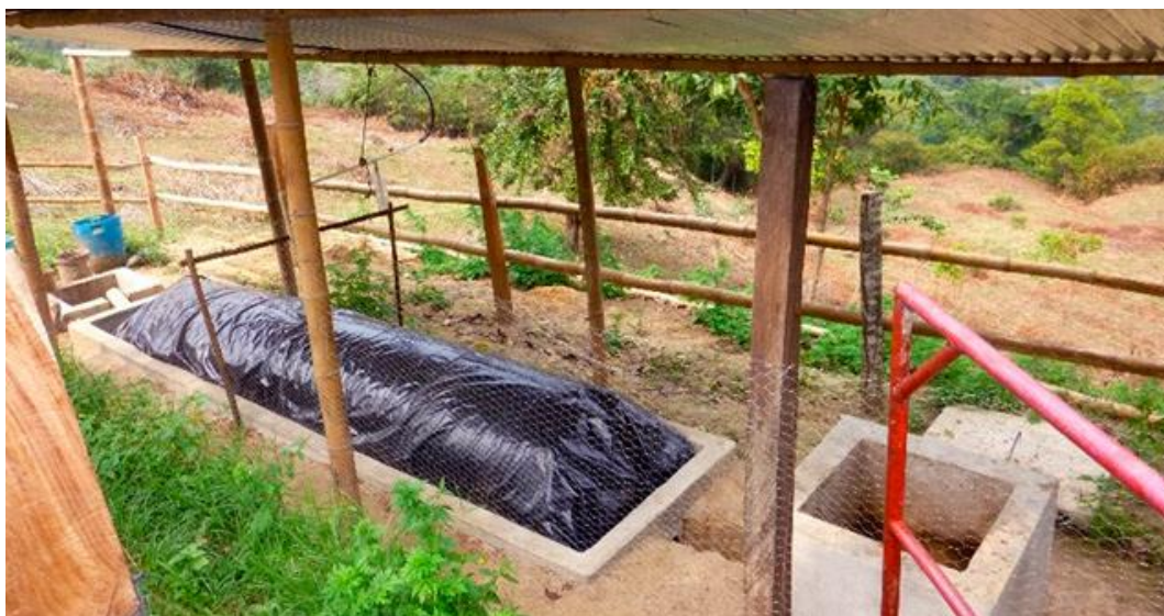
Ilustración 16: Biodigestor en Norte de Santander
