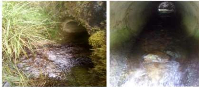
*Ilustración 9 Tubería quebrada La Despensa*
