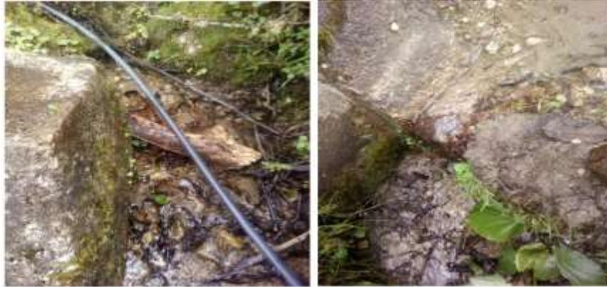
*Ilustración 7. Mangueras captadoras de agua*
