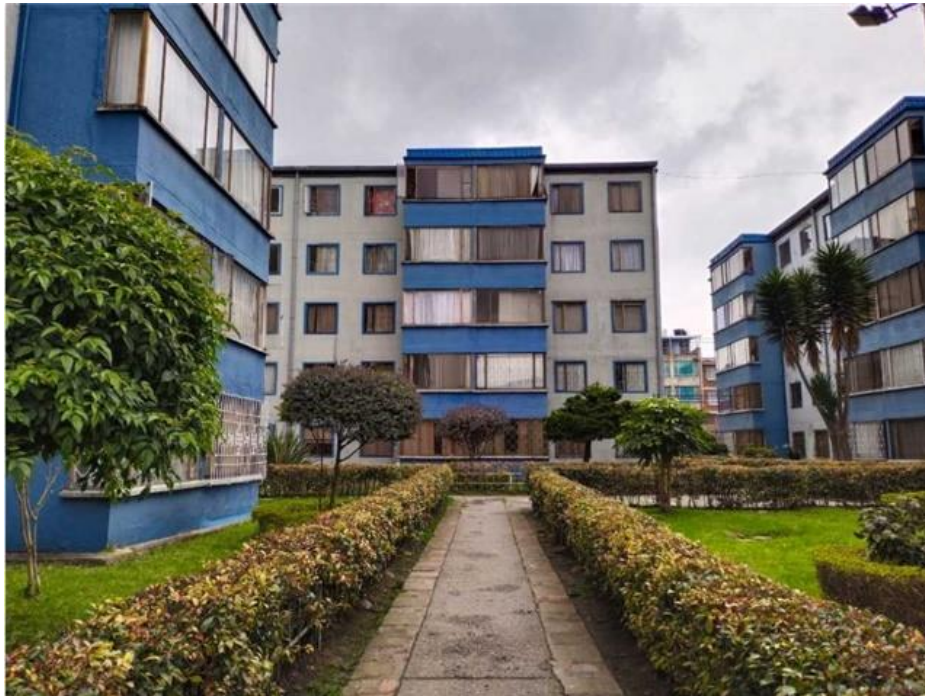
Figura 21. Panorámica de la vivienda.
