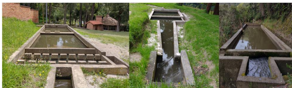
Figura 9. Desarenadores DS-01, DS-02 Y DS-03 de izquierda a derecha.
