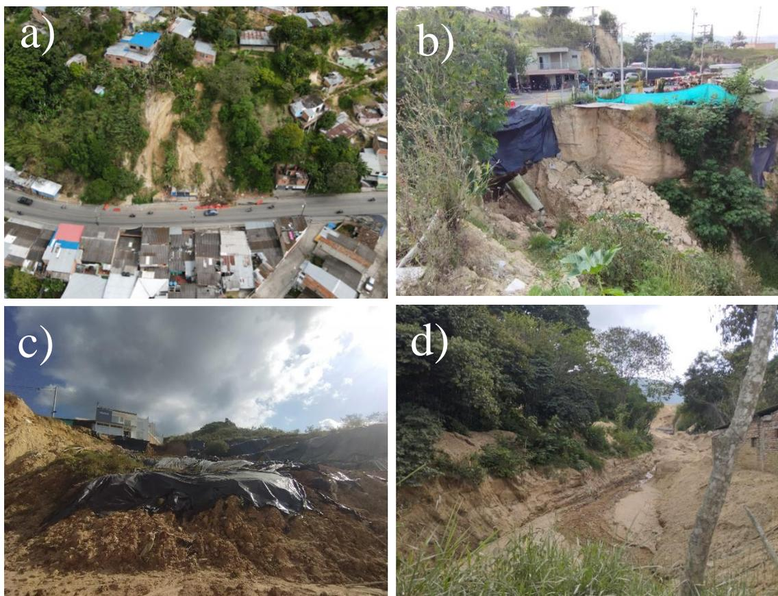
*Nota.* a) Deslizamiento traslacional b) Caída de detritos c) deslizamiento rotacional. d) Flujo de tierra. Fuente: Autor.
