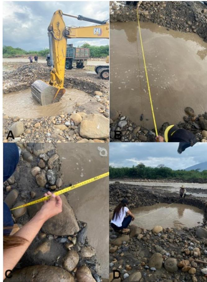
Figura 15. Procedimiento que se llevó a cabo para realizar las granulometrías. A) Haciendo uso de la retroexcavadora se realiza un apique de profundidad promedio de 1.2m. B-C-D) se toman las medidas del apique para verificar que sea de 30m x 30m. Fuente: Autor.
