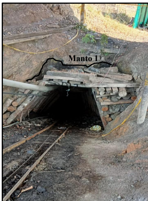
Figura 14: Labores actuales del Manto 1
