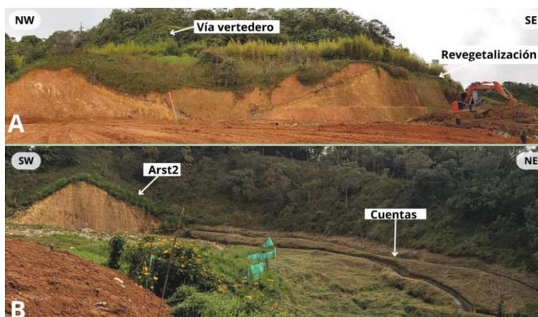
*Nota:* A. Proceso de revegetalización. B. Talud Arst2, se observa una dispersión de residuos que no se encontraban compactados y presentaban además afloramiento de lixiviados (Figura 36).
