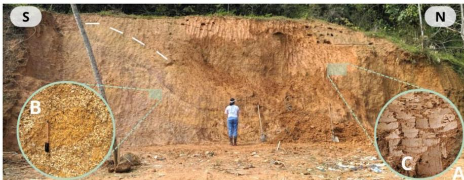
*Nota:* (B) Bloques esferoidales residuales, (C) horizonte residual arcilloso. Fuente el autor.
