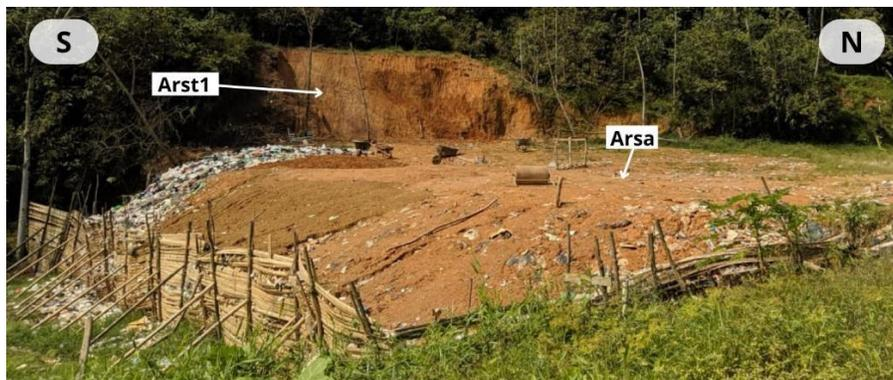
*Nota:* Se pueden observar trinchos en bambú y surcos sobre la pendiente de la celda. Fuente el autor.
