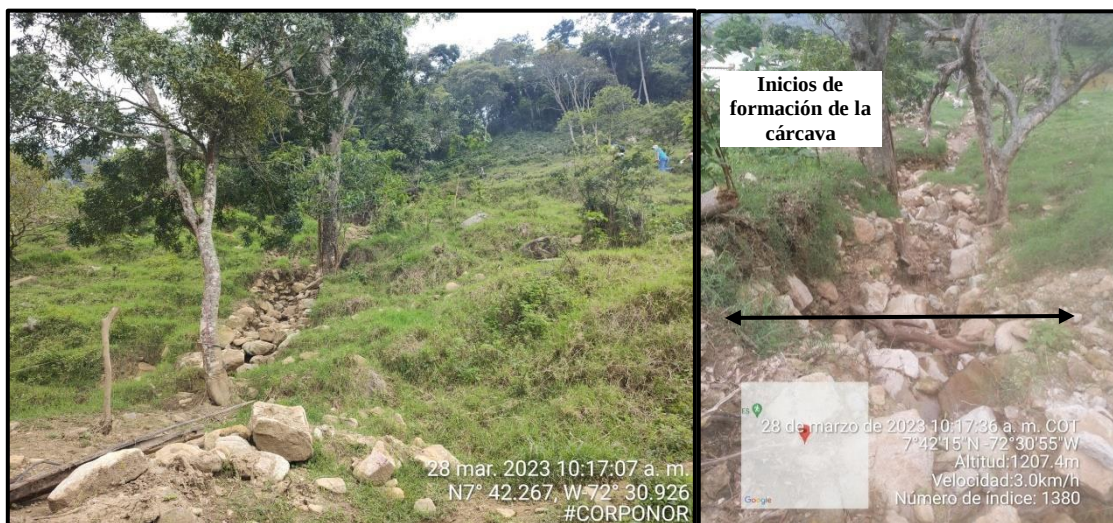
Figura 5. Deslizamiento de rocas canalizado.
