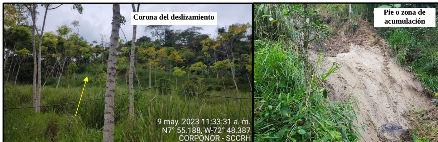
Figura 7. Deslizamiento rotacional en la vía que de Gramalote conduce al municipio de Lourdes.
