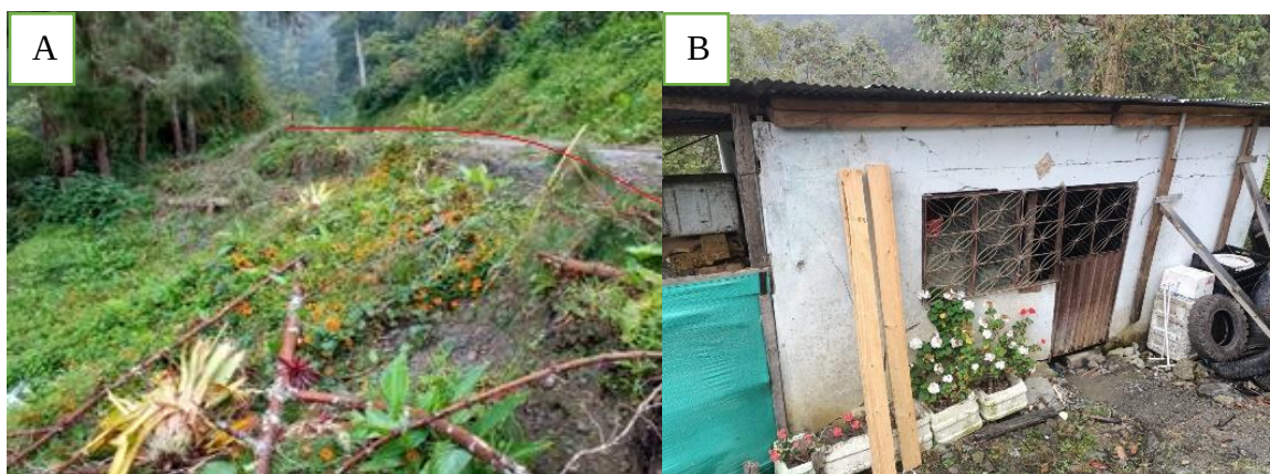
Figura 8 Vía de acceso Insp. San Francisco, municipio El Calvario.
