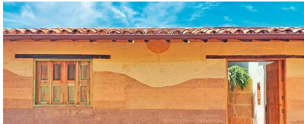
Figura 12. Muro de tapia pisada
