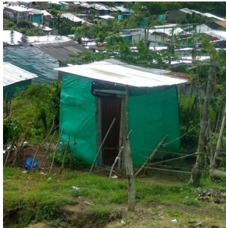
Figura 7. Vivienda en el barrio la fortaleza
