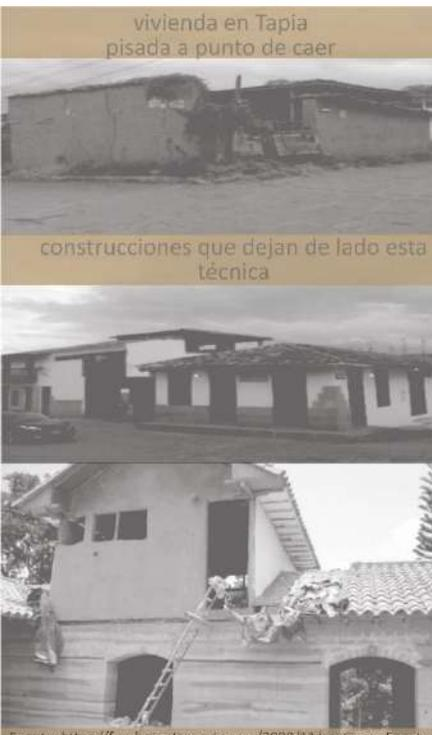
Figura 2.2.6.5.1.1 vivienda en Tapia Fuente: <https://fundaciontierraviva.org/2009/11/casa-pena> Construcción de Vivienda en Tapia en Bucaramanga,
