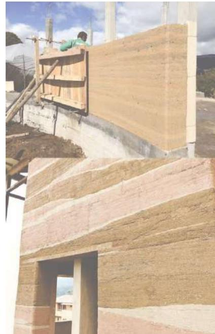
*Figura 2.2.7.2 Proceso Muros Tapial o Tierra apisonada / Rammed Earth*
