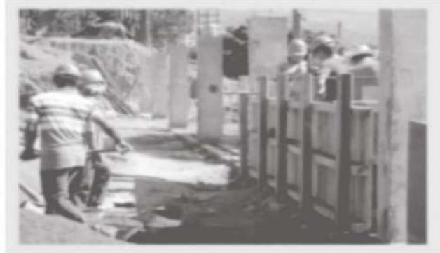
La estructura se puede mimetizar con el interior de los muros en tapias, generando un sistema constructivo mixto en donde la tapia deja de ser un flemento portante a ser un elemento no estructural
