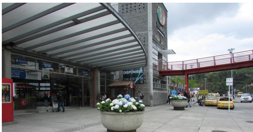
Figura 8 Foto ingreso del Terminal de transportes de Manizales
