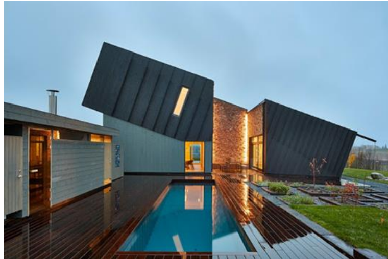
Figura 1.11. Casa Piloto de ZEB
