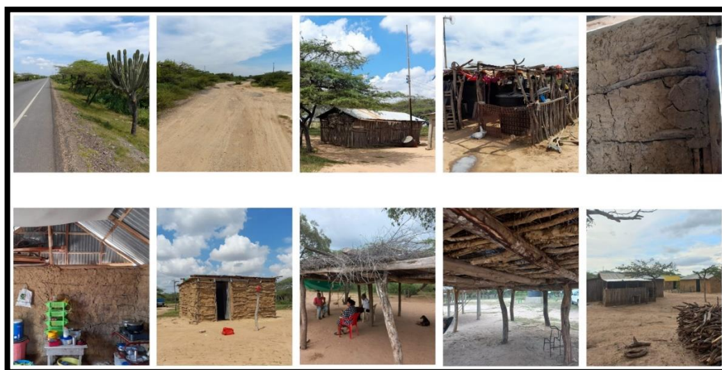
Ilustración 26. Estado Actual de las Viviendas
