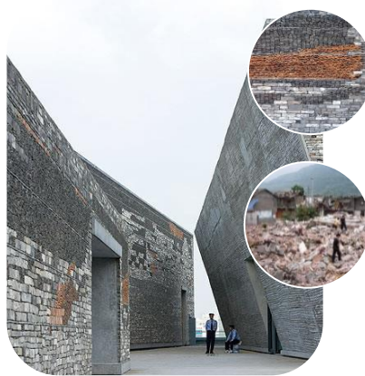
Ilustración 5: Integración de materiales heteróclitos en el recubrimiento exterior del Museo de Historia de la ciudad de Ningbo. (Arquiscopio, 2009)
