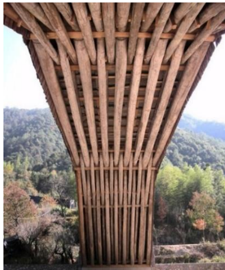
Ilustración 4 : Estructura de madera empleada para el soporte del edificio puente del Museo de Hang Zhou. (Arquiscopio, 2009)
