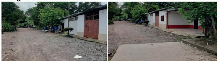
Vía principal del lote
