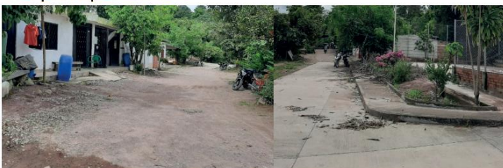
Estado de las vías del sector
