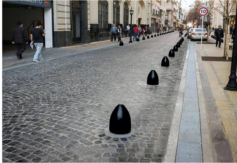
Ilustración 34 Adoquinado de granitillo centro de Buenos Aires en calle Bolívar
