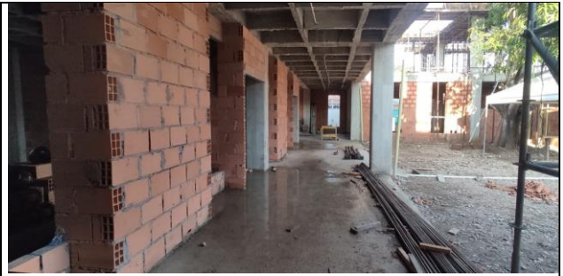
Ilustración 45 Visita de obra-contrato 758 Fuente: fotografía por Pablo Manosalva.
