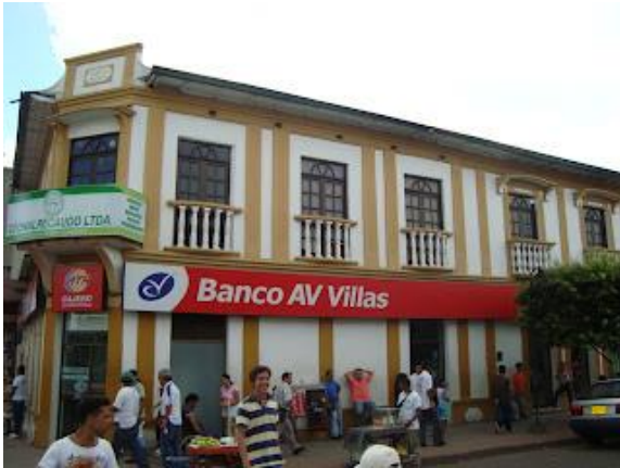
Ilustración 18. Fachada principal casa de Valencia-Florencia, Caquetá
