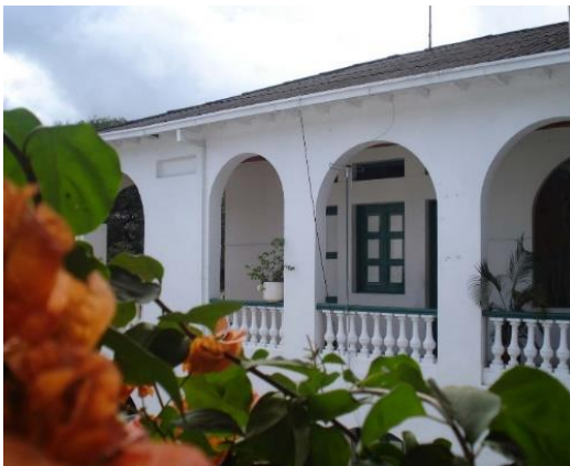
Ilustración 13. Arcos de medio punto, edificio Curipaya-Florencia, Caquetá
