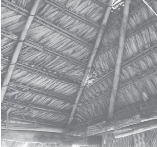
Ilustración 40. Estructura interior de la cubierta.
