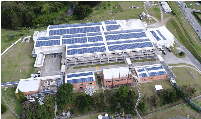
Ilustración 47. Techo con paneles fotovoltaico en la Compañía Nacional de Chocolates.
