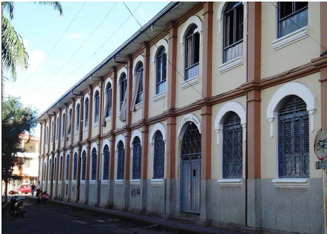
Ilustración 16. Fachada lateral colegio Sagrados Corazones-Florencia, Caquetá
