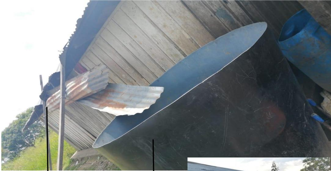
Utilizan zinc para desplazar el agua hasta el tanque.
