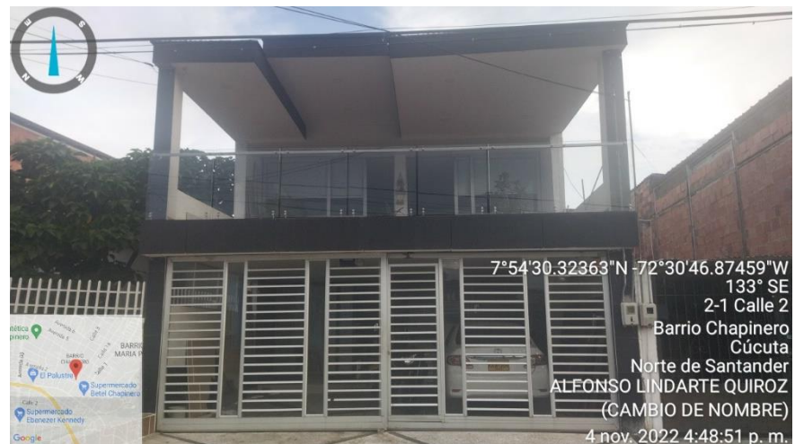
Figura 55. Registro Fotográfico de Fachada. Fuente: Elaboración Propia en una Visita Realizada.
