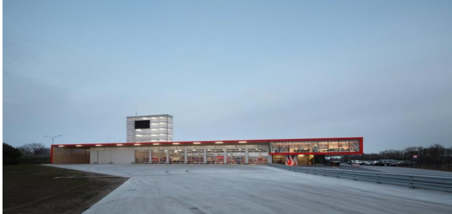
Figura 11. Vista Fachada Frontal Fuente: Compagnie O Architects
