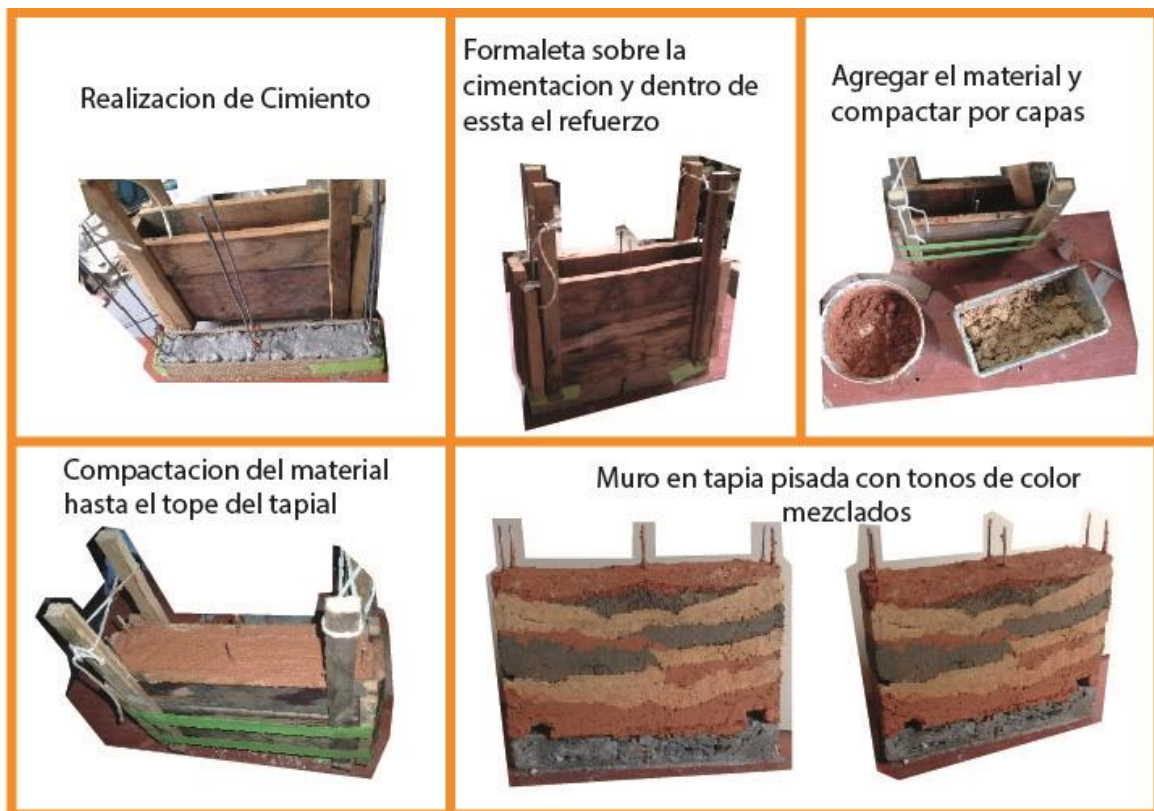
Imagen 46- 47: Realización paso a paso Maqueta tapia pisada. Realización propia del autor. (2020)
