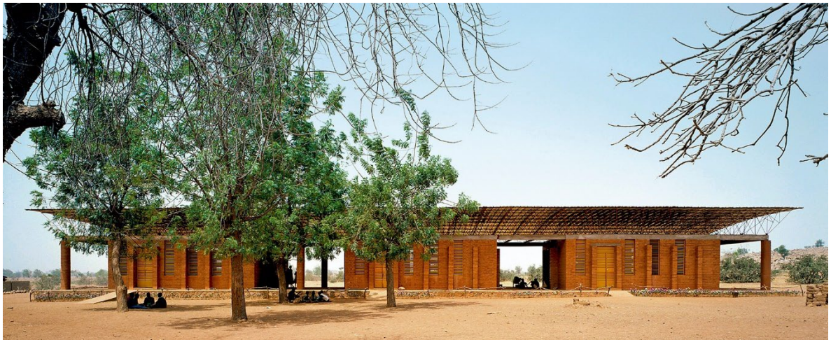
fotografía 23. Fachada, Escuela primaria, Gando – Burkina Faso. Revista Arquitectura Viva. 2022.
