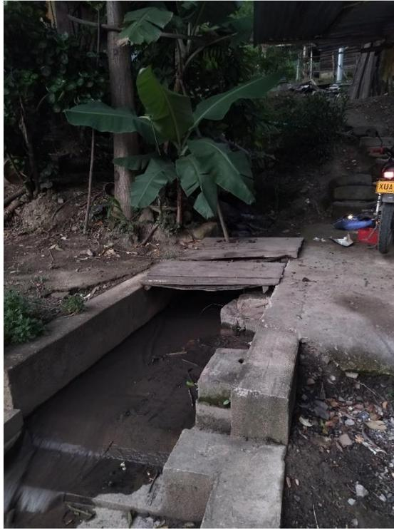
*Ilustración 62: sistema de manejo de aguas grises: Fuente: Elaboración propia*
