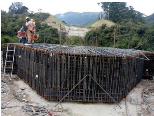
Ilustración 17: Encepado Estribo y Pila
