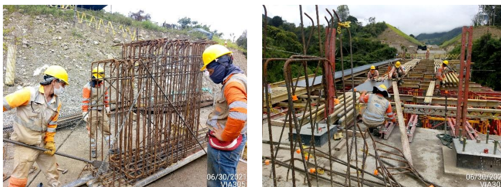
Ilustración 19: Armado de acero de vigas y Tablero Vano 1
