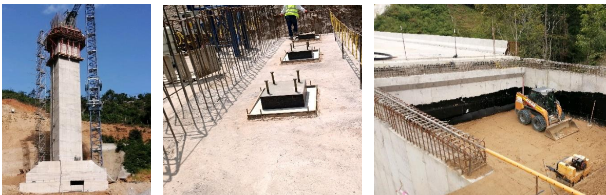
Ilustración 14: Pila, Neoprenos, Muro y aletas.
