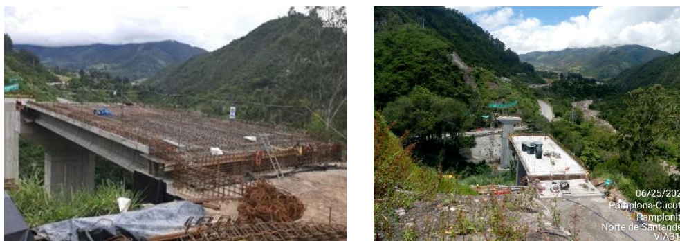
Ilustración 21: Vigas y losa Vano 1
