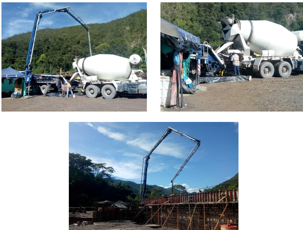
Ilustración 32. Vaciado de Concreto
