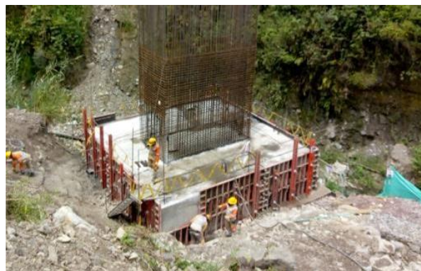
Ilustración 17: Encepado Estribo y Pila
