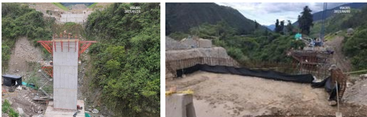
Ilustración 18: Fuste de la Pila, Espalda y Aletas
