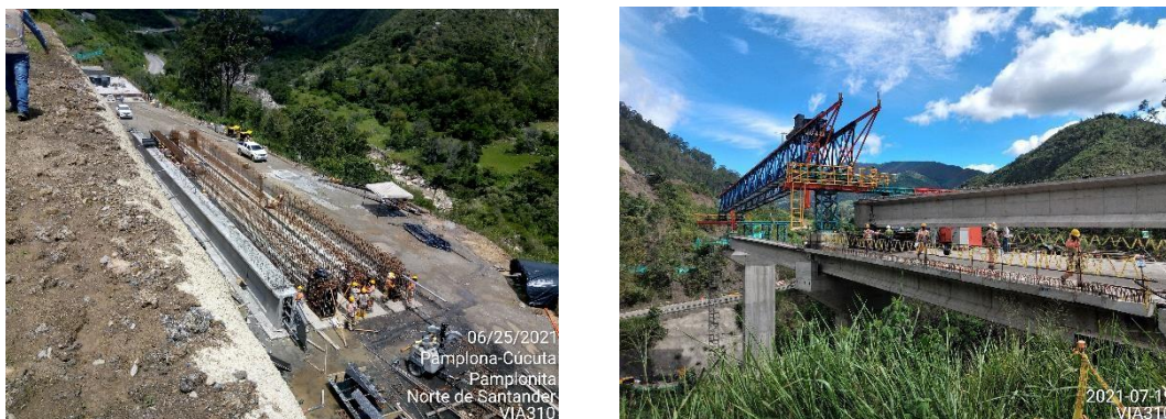
Ilustración 22: Vigas, Izaje Vano 2
