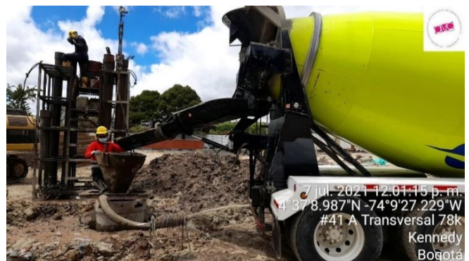
Figure 15 Vaciado del pilote. Fuente: Propia,
