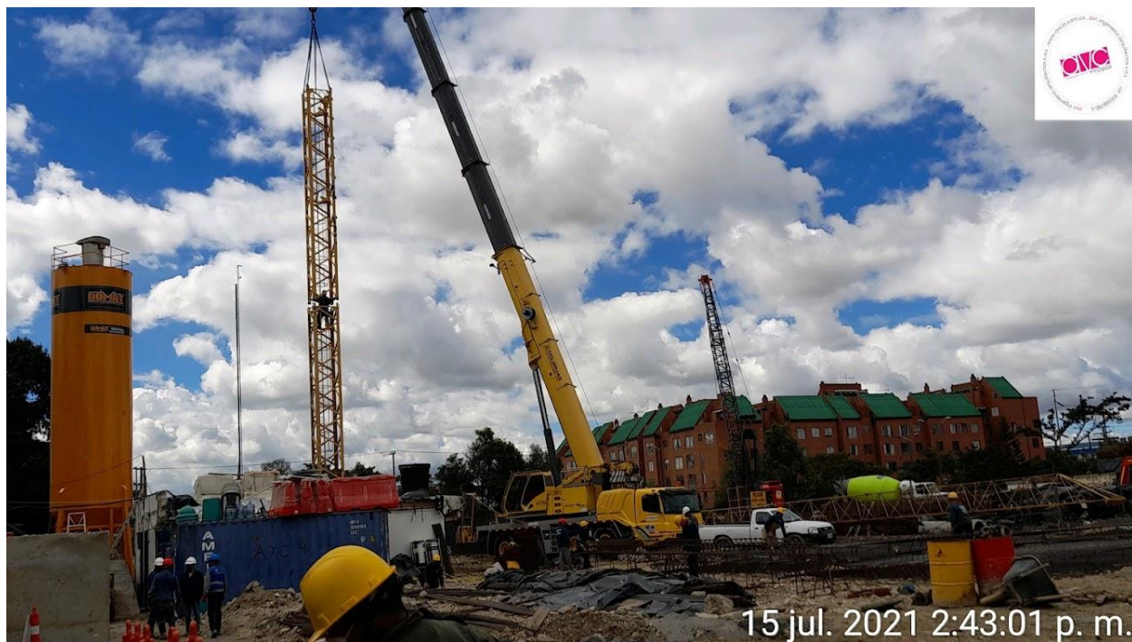
Figure 58 Montaje torre grúa con grúa Grove TM 1500. Fuente: Propia.
