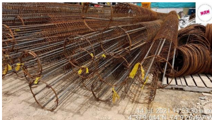
Figure 14 Acero de pilotes revisado. Fuente: Propia.
