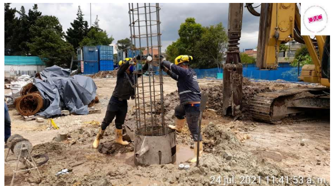
Figure 16 Supervisión instalación de la parrilla del pilote
