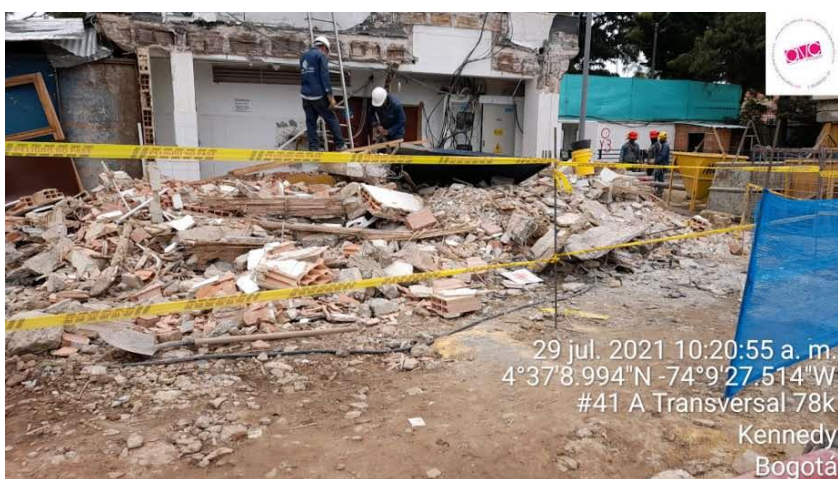
Figure 40 Delimitación zona de trabajo. Fuente: Propia.
