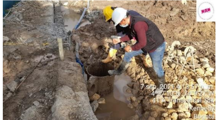
Figure 15 Medición de la excavación para pilote.
