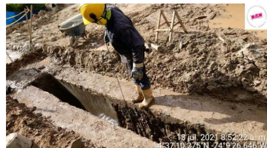
Figure 19 Medición de la excavación del muro pantalla. Fuente: Propia.
