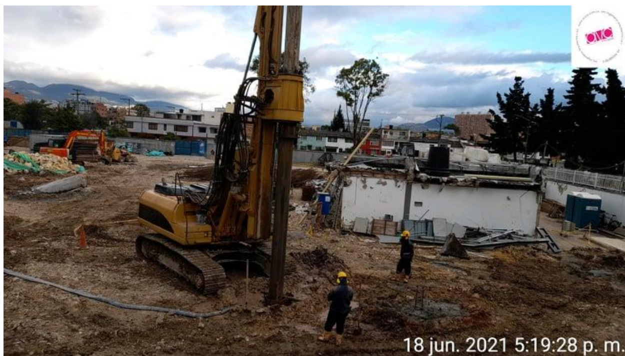
Figure 61 Piloteadora AF 110 IMT International. Fuente: Propia.
