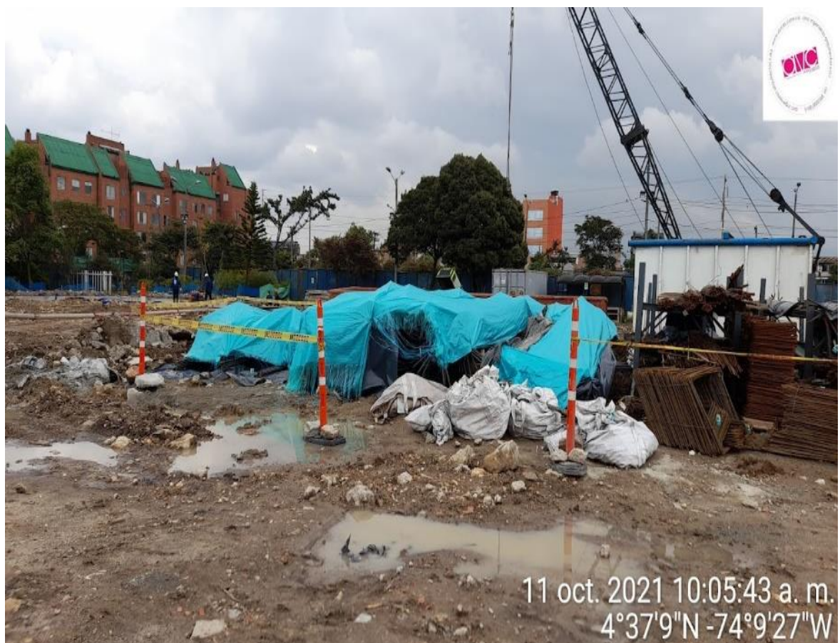
Figure 26 Acopio de acero de refuerzo de manera correcta. Fuente: Propia.
