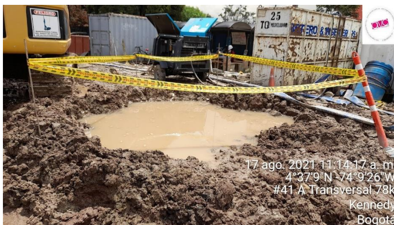
Figure 41 Señalización excavación. Fuente: Propia
