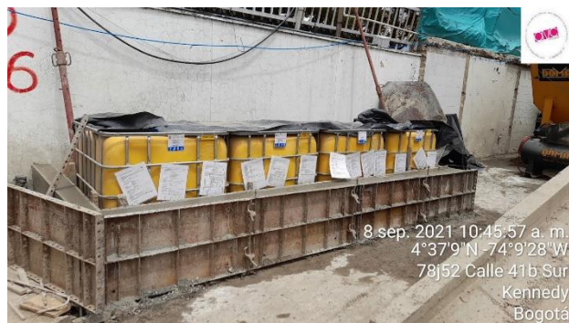
Figure 30 Acopio de aditivos.. Fuente: Propia.
