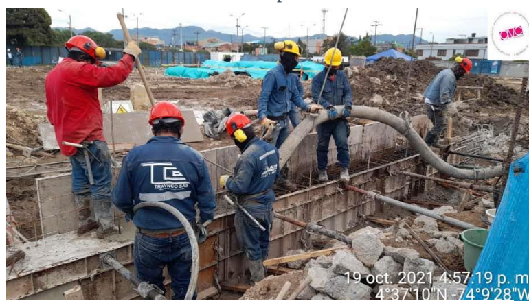
Figure 22 Fundida viga cabezal. Fuente: Propia
