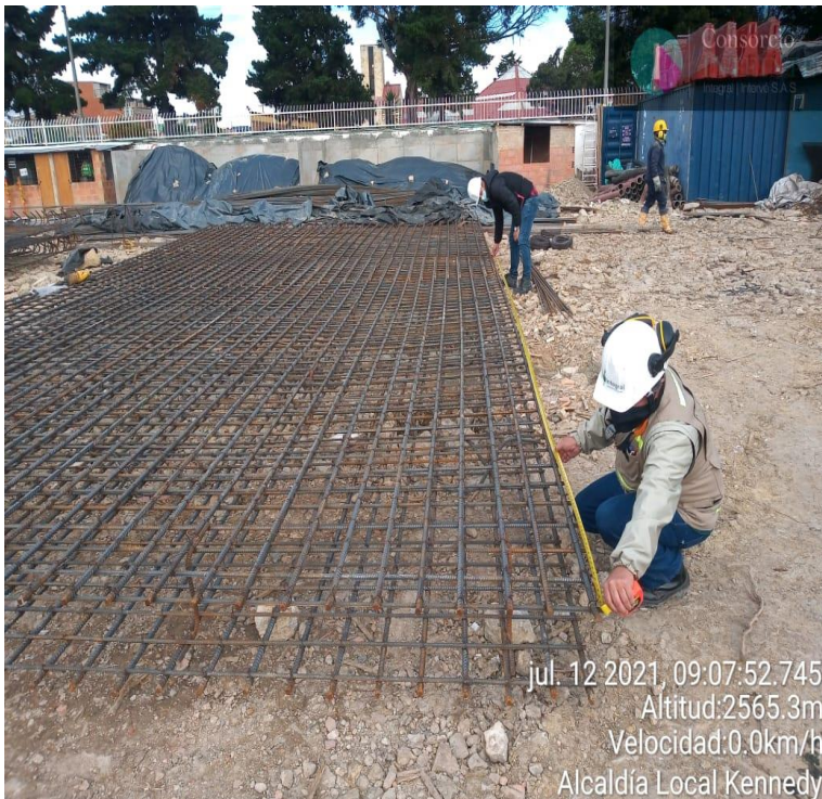
Figure 16 Revisión armado de parrillas muro pantalla. Fuente: Propia.
