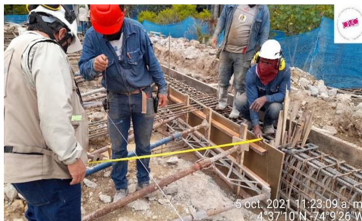
Figure 21 Verificación de armado de acero, niveles, ejes y distancias. Fuente: Propia.
