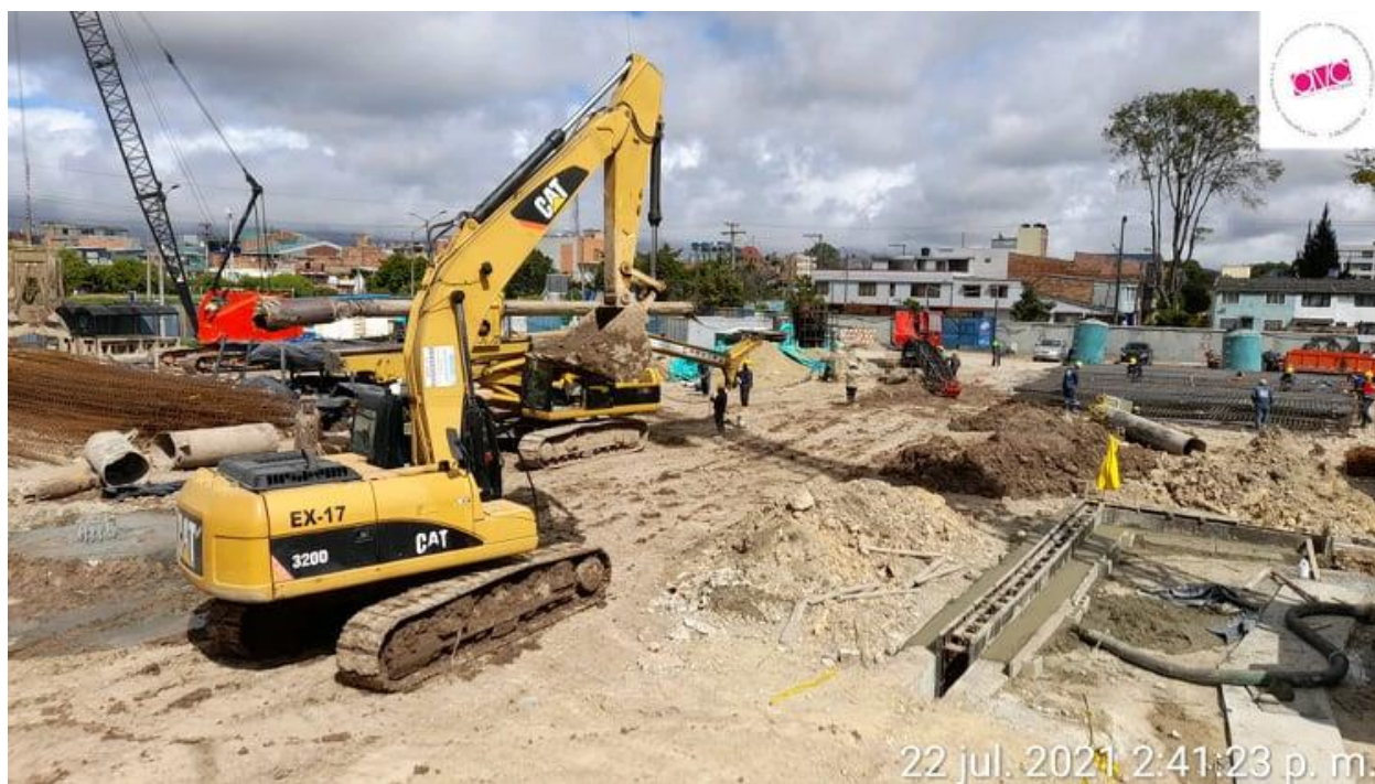
Figure 62 Retro excavadora CAT 320D. Fuente: Propia.
