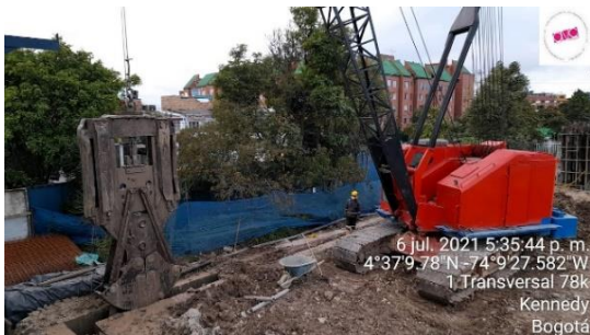
Figure 18 Excavación muro pantalla Fuente: Propia
