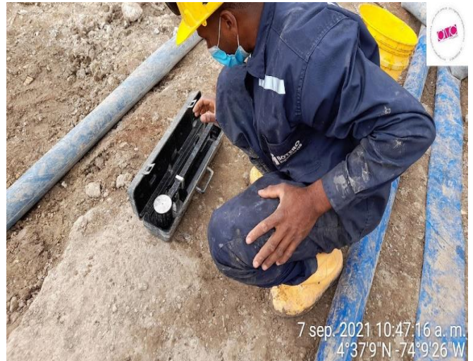
Figure 33 Ensayo de densidad.. Fuente: Propia.
