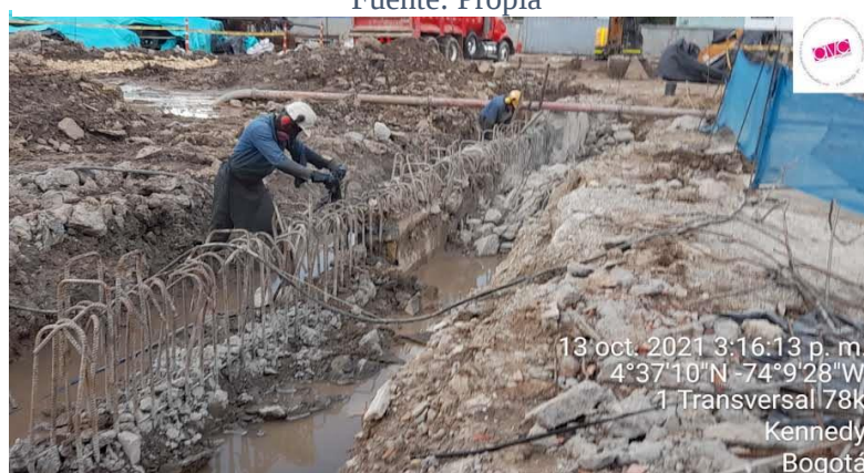
Figure 23 Descabece de muro pantalla. Fuente: Propia.
