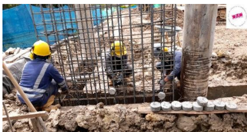
Figure 20 Seguimiento instalación muro pantalla Fuente: Propia.
