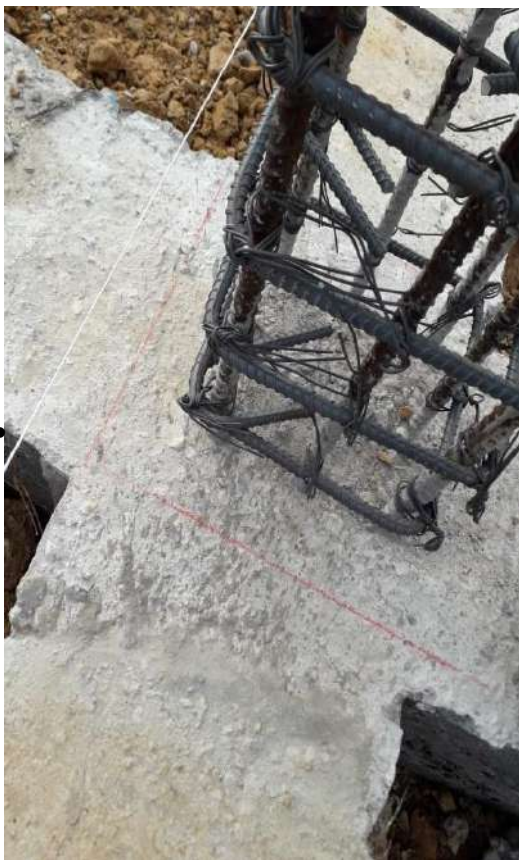
Formaleteado de columnas
