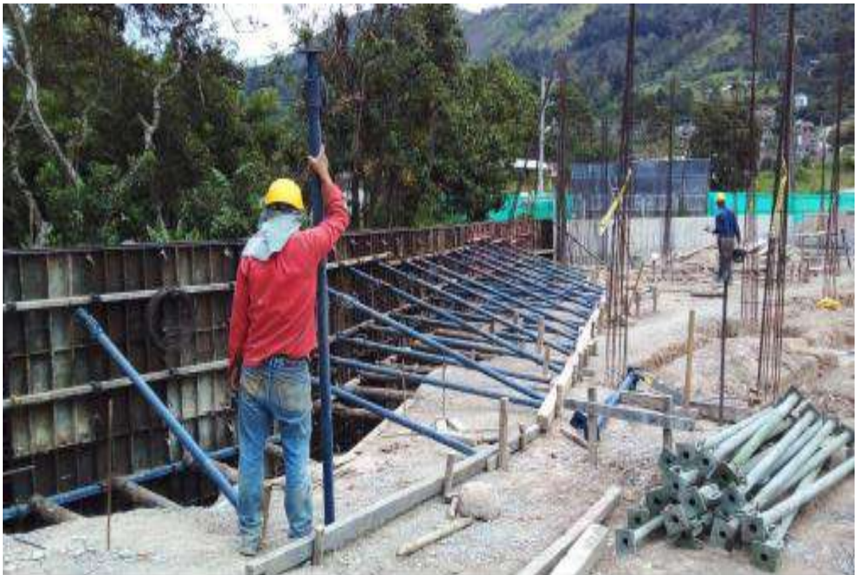
Formaleta para muro trancada
