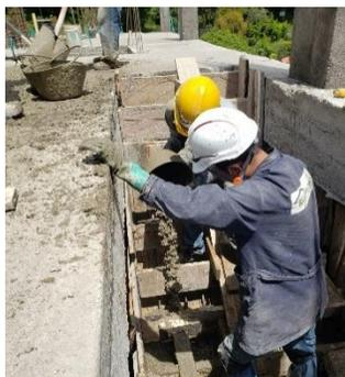
*Ilustración 33 Registro fotográfico, vaciado del concreto*
