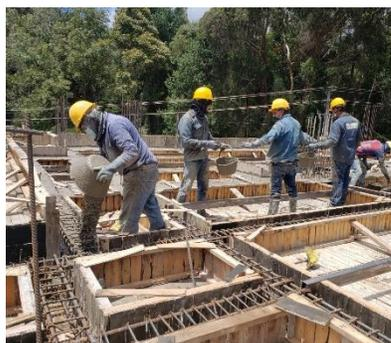
*Ilustración 34 Registro fotográfico, vaciado del concreto*
