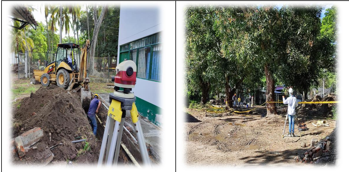
Ilustración 6 Localización y replanteo
