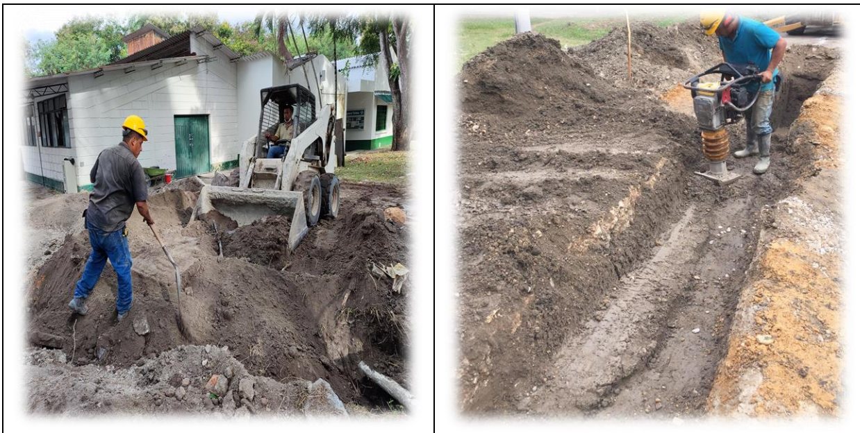
Ilustración 12 Lleno con material del sitio proveniente de la excavación
