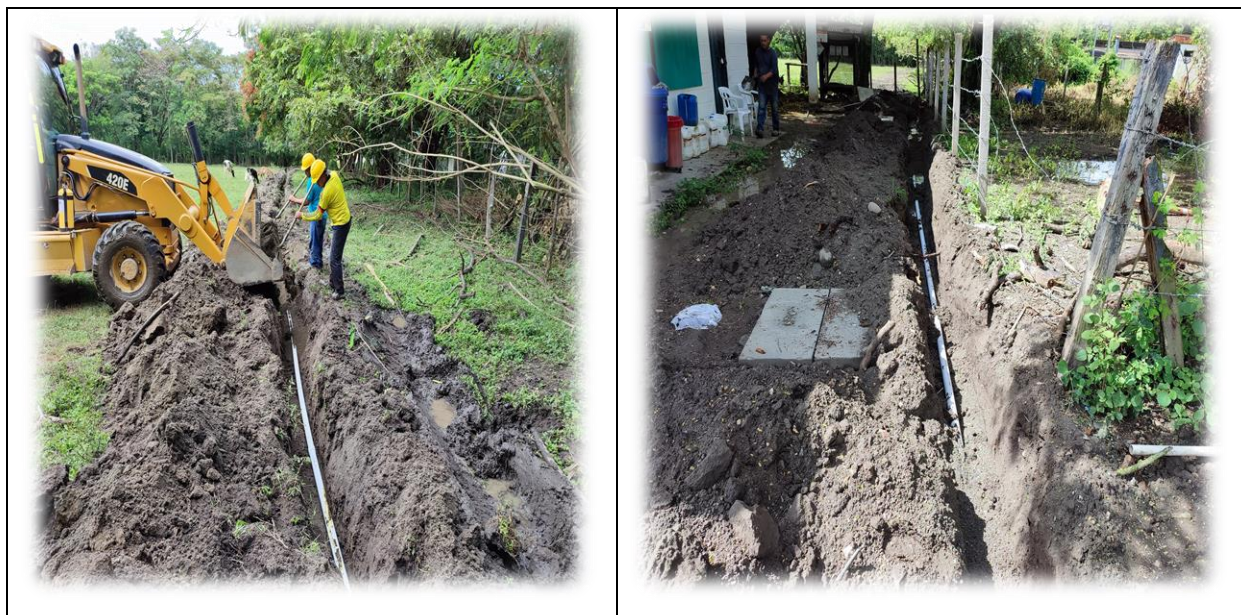
Ilustración 21 Instalación tubería Ø 2"
