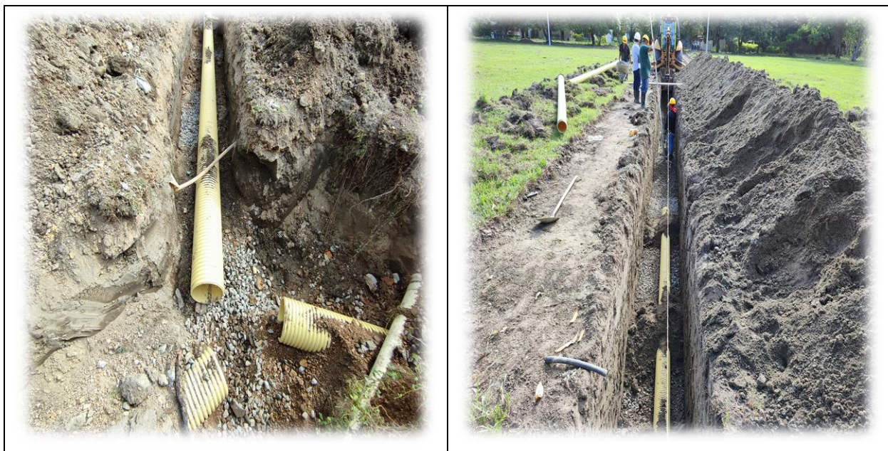
Ilustración 10. Instalación de tubería
