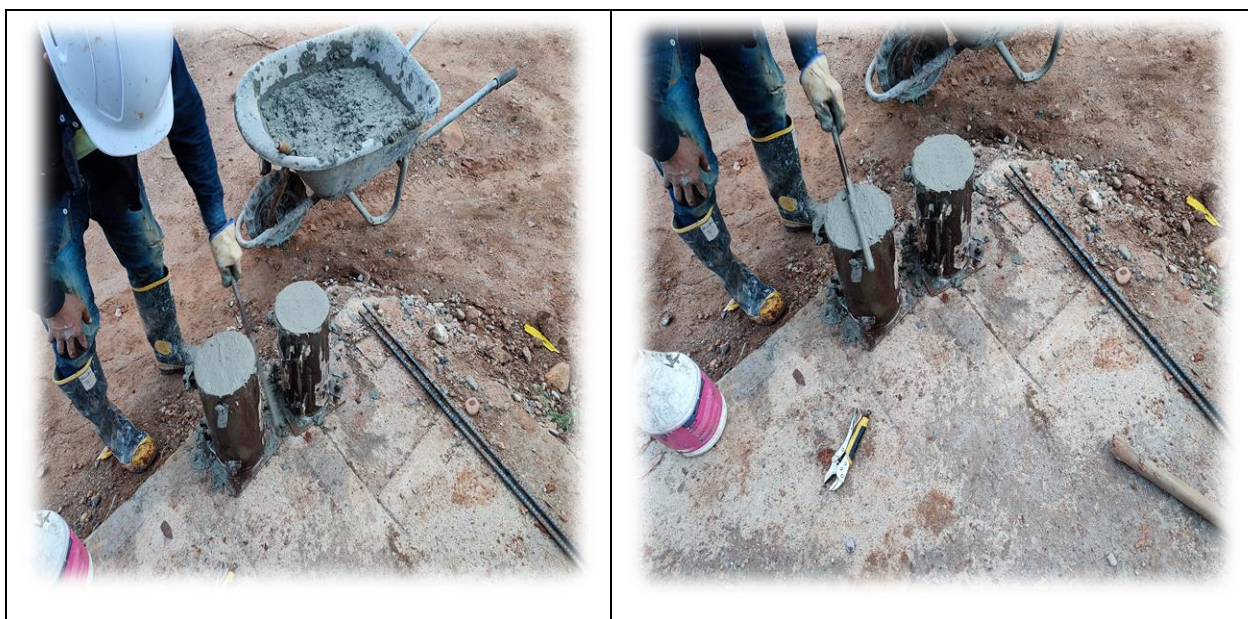
Ilustración 17 Elaboración de cilindros en obra
