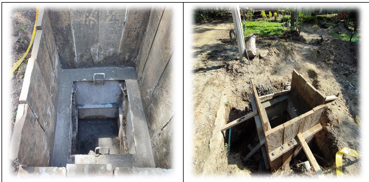
Ilustración 15 Construcción cajas de inspección.
