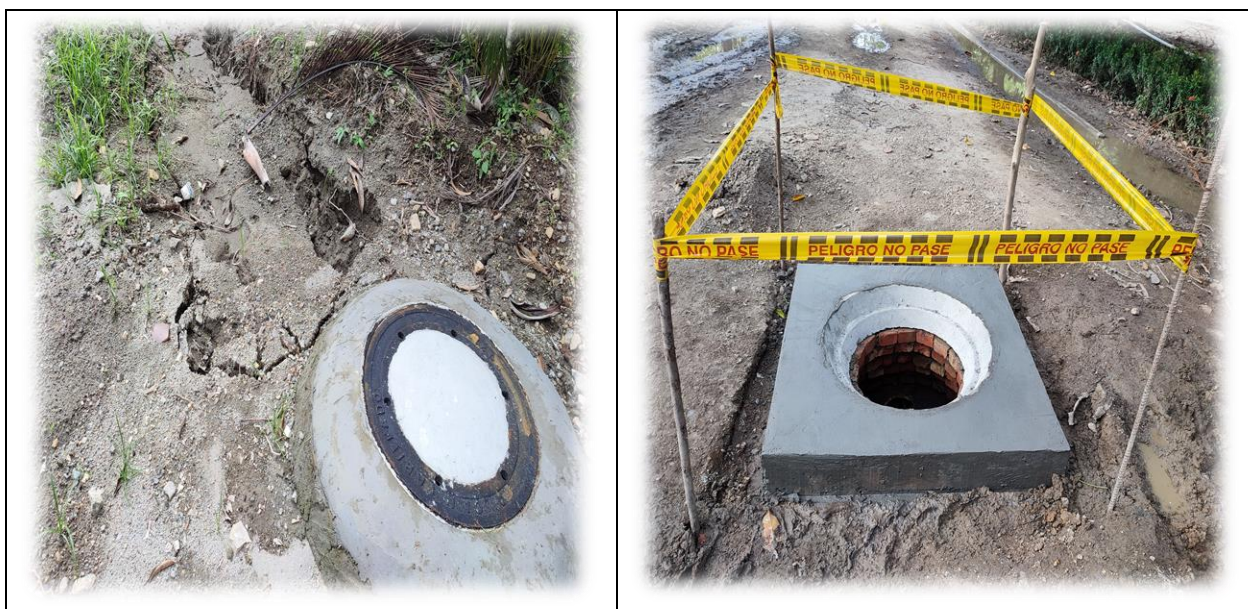
Ilustración 14 Instalación de tapas
