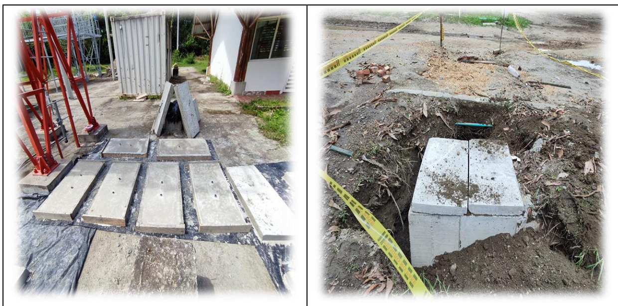
Ilustración 16 Tapas en concreto
