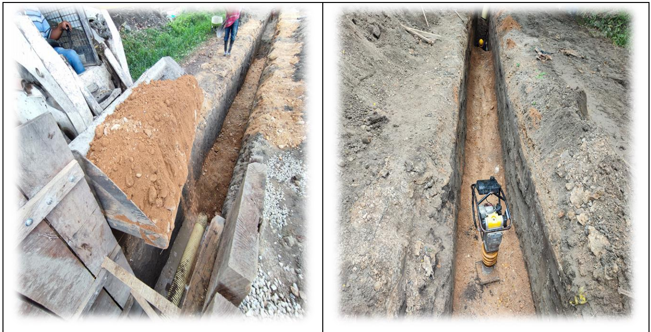
Ilustración 11 Capa de material seleccionado compactado.
