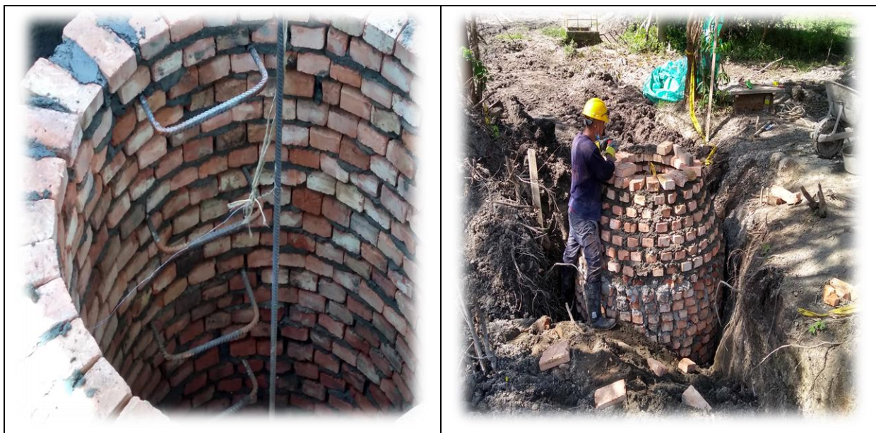
Ilustración 13 Construcción pozos de inspección
