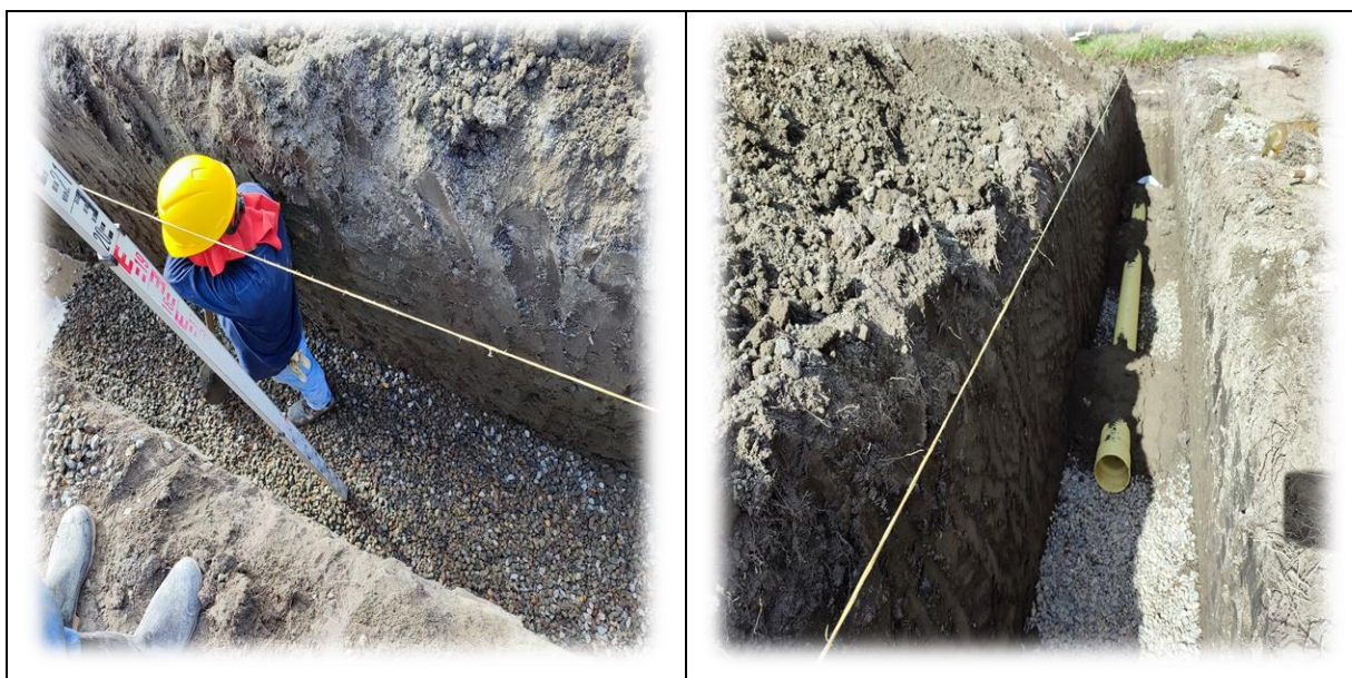
Ilustración 9 Capa de agregado
