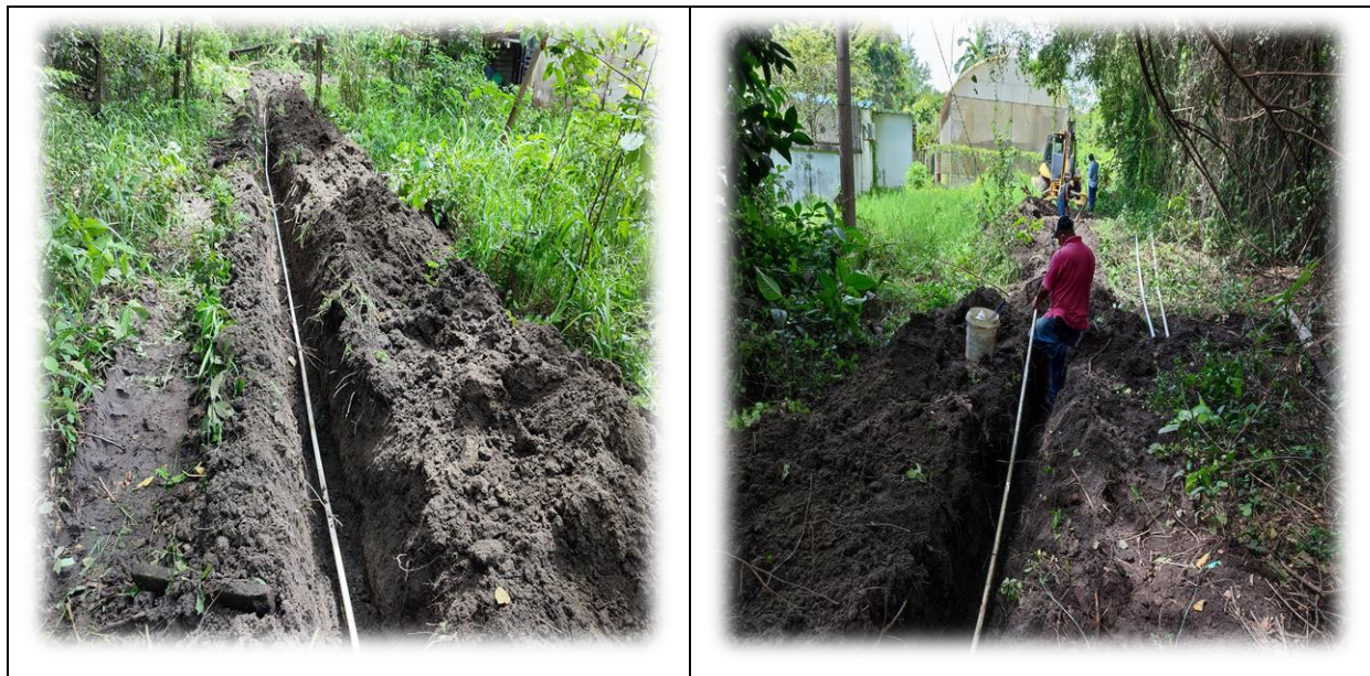
Ilustración 20 Instalación tubería 1"
