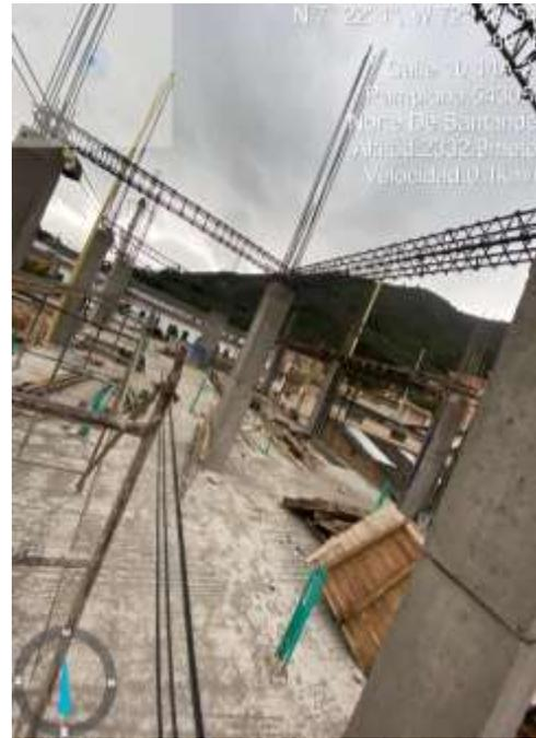
*Nota:* Se supervisan las actividades de amarre de acero, encofrado de vigas y fundición de vigas.
