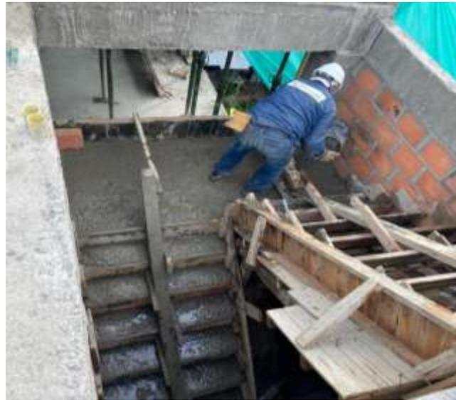
*Ilustración 24 Vaciado de concreto en escaleras.*
