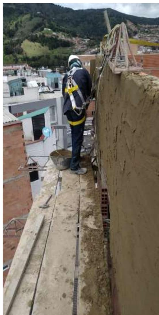
*Ilustración 34 Implementación de arnés de seguridad y línea de vida trabajo en alturas*
