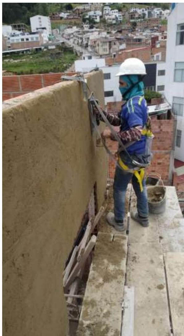
*Ilustración 33 Implementación de arnés de seguridad y línea de vida trabajo en alturas*
