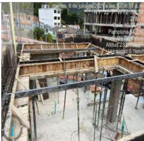
Ilustración 5 Instalación de perfiles estructurales
