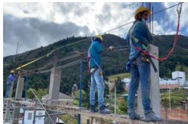
*Ilustración 38 Verificación del uso de elementos de protección en trabajo de alturas*
