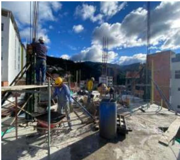
*Ilustración 25 Vaciado de concreto columnas de entrepiso*
