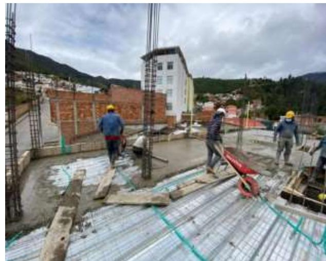
*Ilustración 26 Vaciado de concreta placa de entrepiso.*
