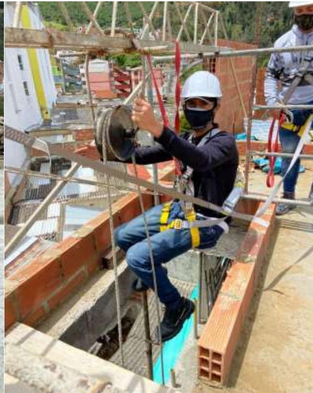
*Ilustración 36 Inspección y manejo de nuevos elementos de trabajo en alturas*
