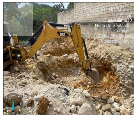
Figura 14. Localización y excavación zapatas
