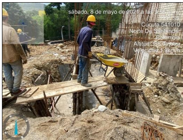
Figura 50. Transporte de concreto
