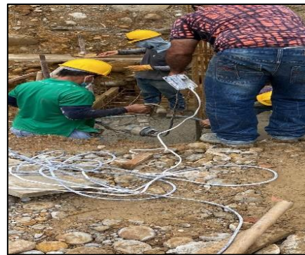
Figura 23. Supervisión vibro compactador
