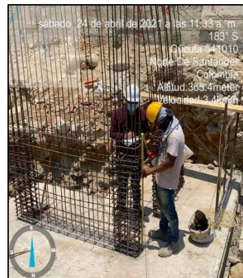
Figura 24. Verificación de acero
