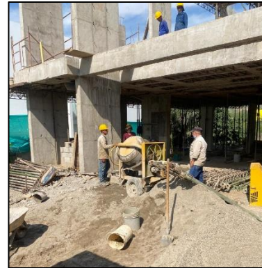
Figura 44. Arena y mezcla
