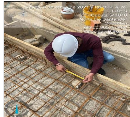
Figura 20. Verificando especificaciones técnicas
