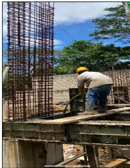
Figura 51. Vibrado de concreto
