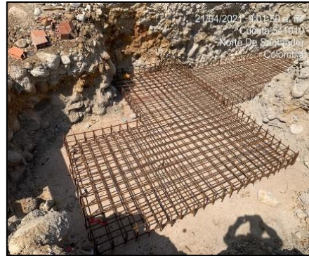
Figura 19. Instalación del acero
