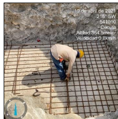
Figura 18. Ubicación acero zapatas
