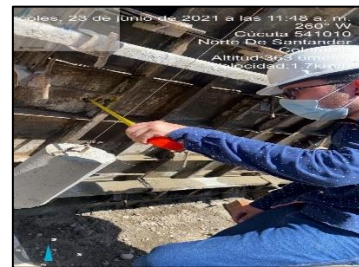
Figura 35. Comprobación de aplomada
