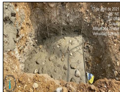
Figura 17. Procedimiento del ciclópeo
