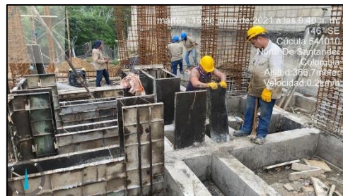
Figura 33. Concreto de viga cimentación
