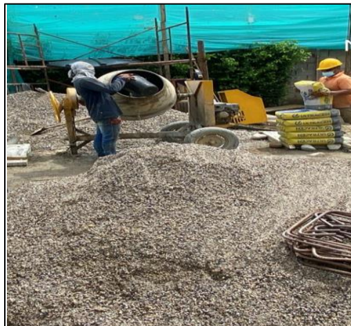
Figura 49. Preparación de concreto
