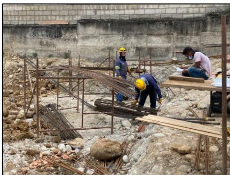
Figura 9. Despiece de acero
