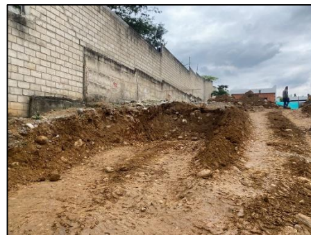
Figura 10. Movimiento de tierra
