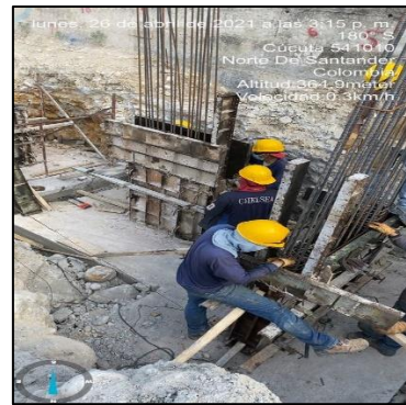
Figura 26. Instalación de formaleta
