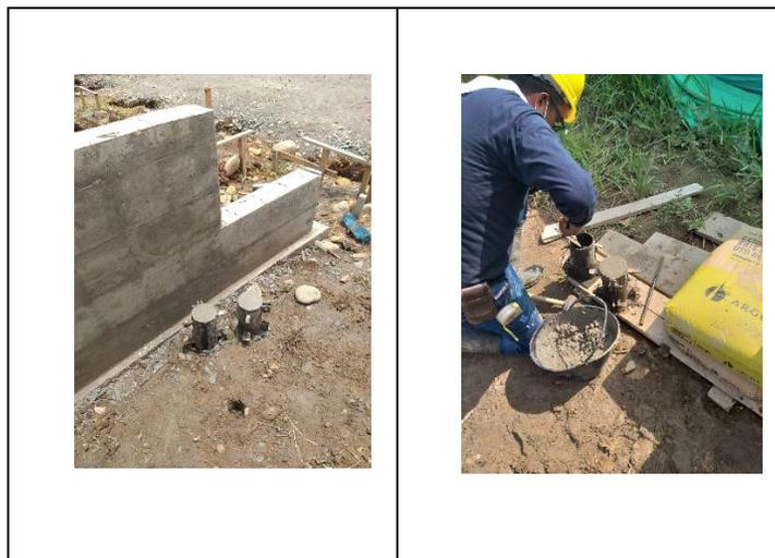
Ilustración 28 Toma de Muestra para Ensayos
