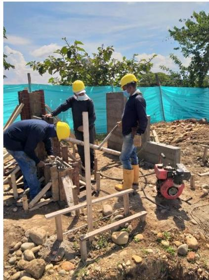
Ilustración 23 Utilidad de Vibrador de Concreto en Obra
