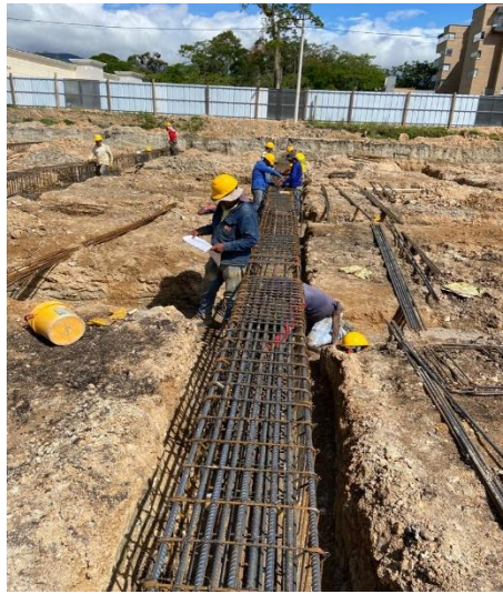
Ilustración 25. Armado de acero vigas, fuente: Cifuentes Mafla
