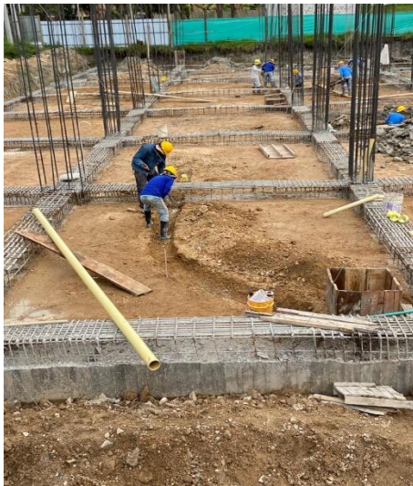
Ilustración 36. Excavación red pluvial, fuente: Cifuentes Mafla
