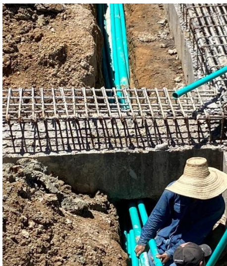
Ilustración 38. Instalación de red eléctrica, fuente: Cifuentes Mafla
