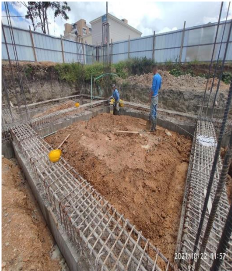
Ilustración 30. Relleno y nivelación de placa flotante, fuente: Cifuentes Mafla
