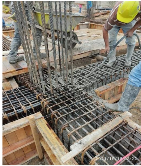
Ilustración 28 Vibrado de concreta fuente: Cifuentes M
