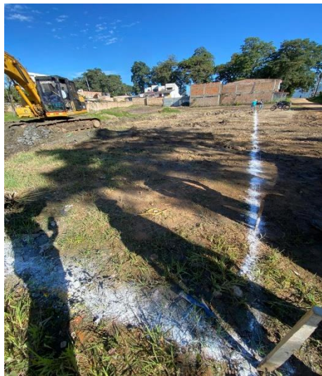
Ilustración 12. delimitación de excavación fuente: Cifuentes Mafla
