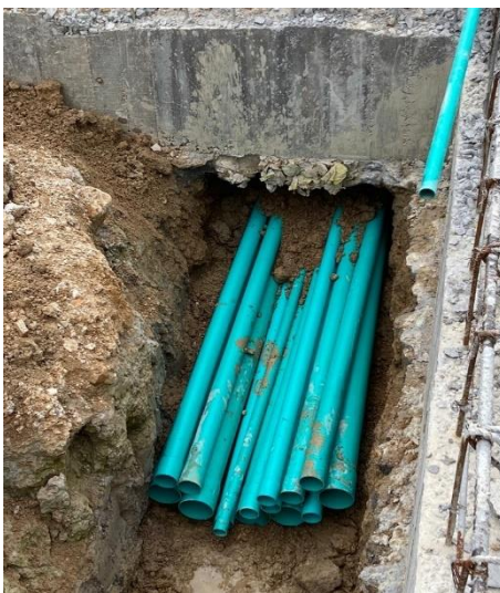
Ilustración 39. Pasante bajo viga de red eléctrica, fuente: Cifuentes Mafla
