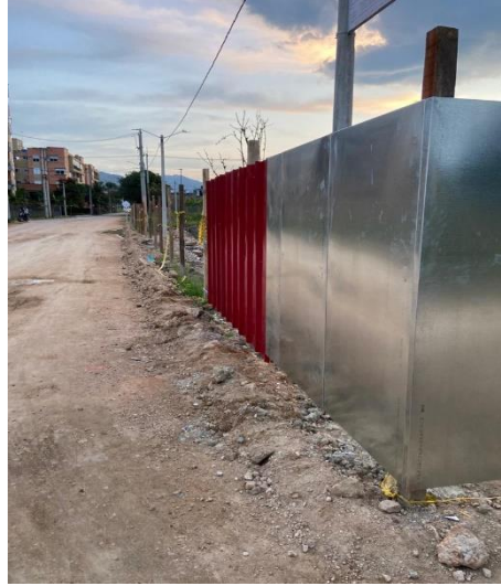
Ilustración 16. Instalación de tejas tipo zinc, fuente: Cifuentes Mafla
