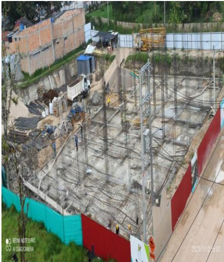
Ilustración 41. Inicio de armado de acero placa de cimentación, fuente: Cifuentes Mafla
