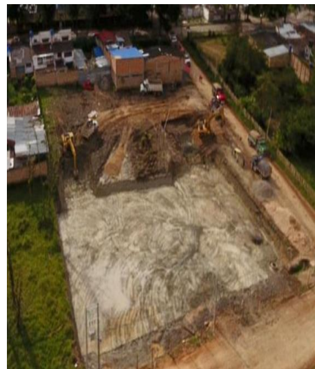
Ilustración 14 excavación mecánica a nivel de cimentación fuente: Cifuentes Mafla
