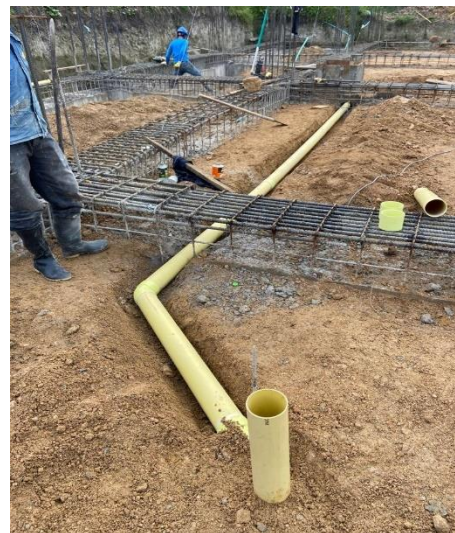
Ilustración 37. Instalación de tubería red pluvial, fuente: Cifuentes Mafla
