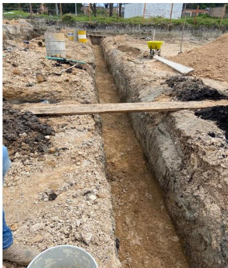
Ilustración 22. Alistando en recebo-cementó, fuente: Cifuentes Mafla
