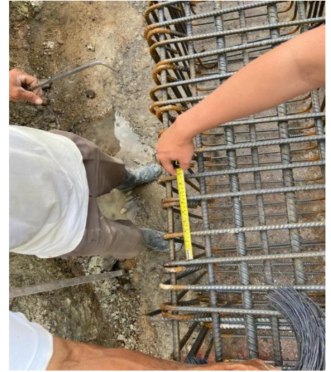
Ilustración 26. Verificación de espaciamiento de acero, fuente: Cifuentes Mafla
