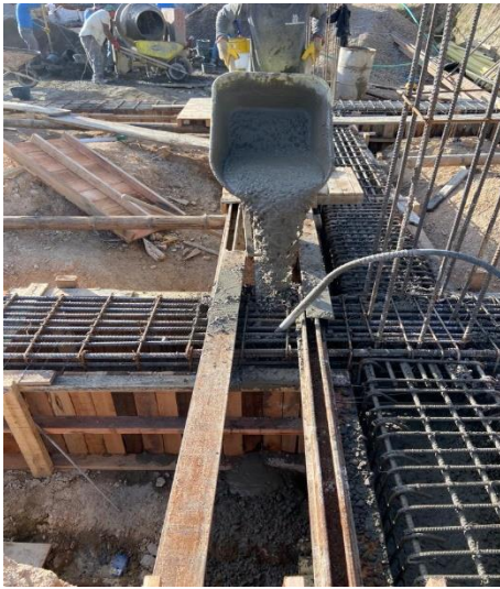
Ilustración 27 vaciado de concreta fuente: Cifuentes M
