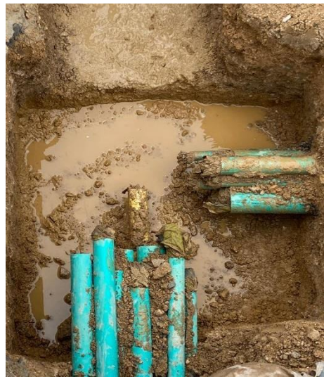
Ilustración 40. Cajilla de red eléctrica, fuente: Cifuentes Mafla
