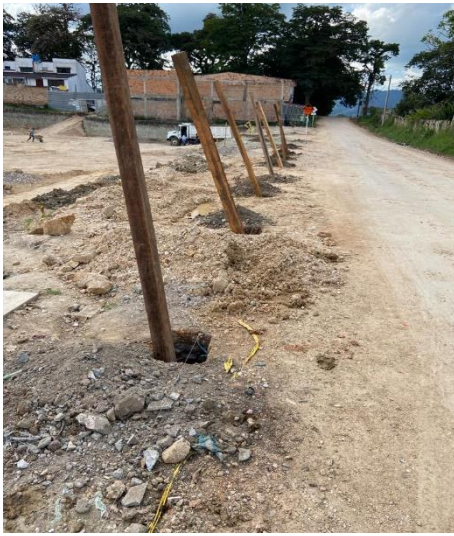
Ilustración 15. instalación de poste cerramiento provisional, fuente: Cifuentes Mafla
