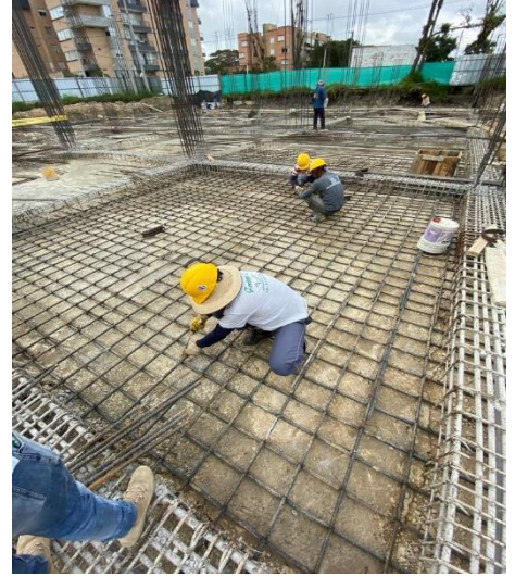
Ilustración 43 .Amarrado de acero, fuente: Cifuentes Mafla
