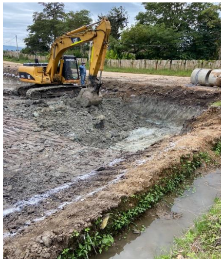
Ilustración 13. Inicio de excavación fuente: Cifuentes Mafla
