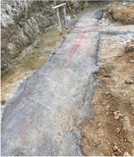
Ilustración 24. Demarcación de ejes, fuente: Cifuentes Mafla
