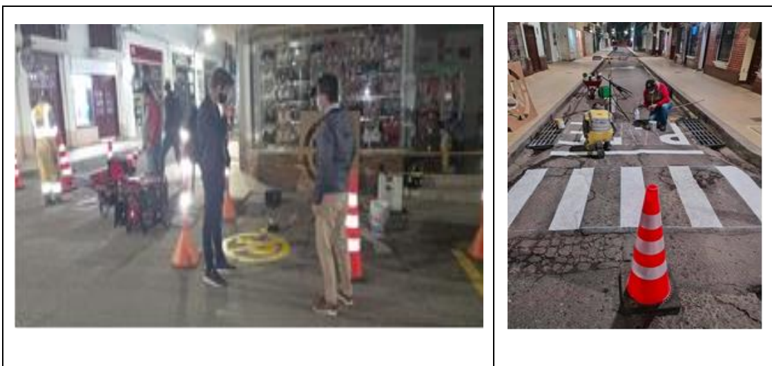
Evidencia de las obras de pintura y demarcación vial
