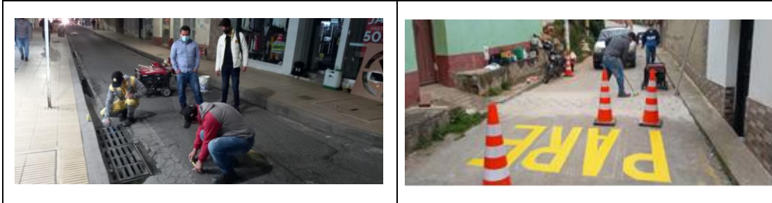
Evidencia de las obras de pintura y demarcación vial
