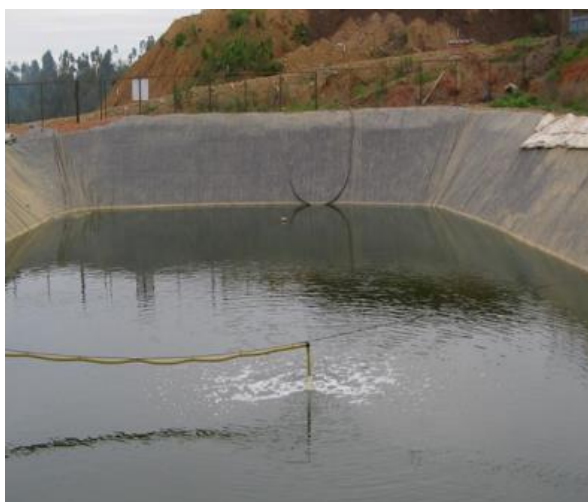
Ilustración 2: Tanque de reacción o tratamiento de lixiviados
