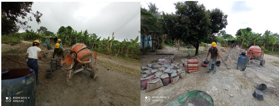
Ilustración 25 Concreto en obra
