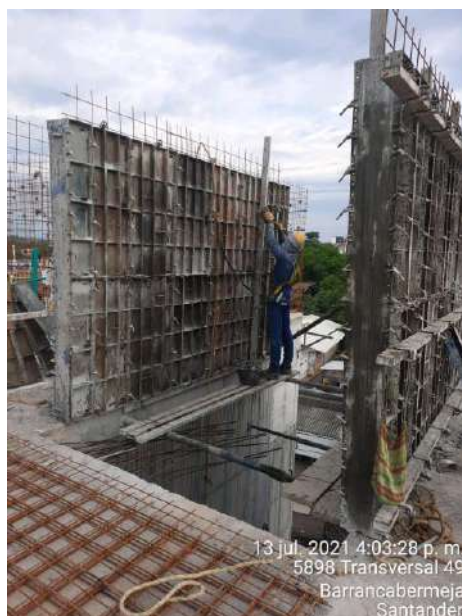
Ilustración 16. Obrero con su respectivo arnés de seguridad.
