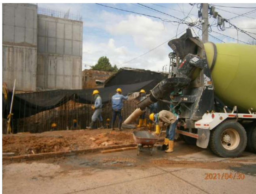
Ilustración 18. Aplicación de concreto para tanque de almacenamiento. Fuente: Propia
