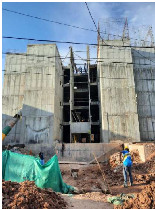
Ilustración 4. Fachada del proyecto. Fuente: Propia
