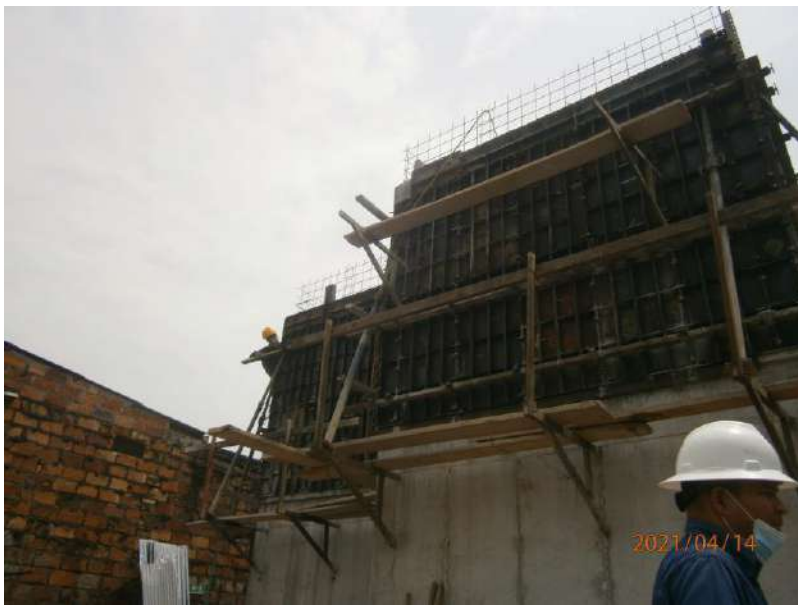
Ilustración 17. Instalación de formaleta para apartamento 208. Fuente: Propia
